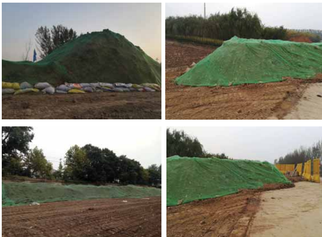
临时拦挡、遮盖
