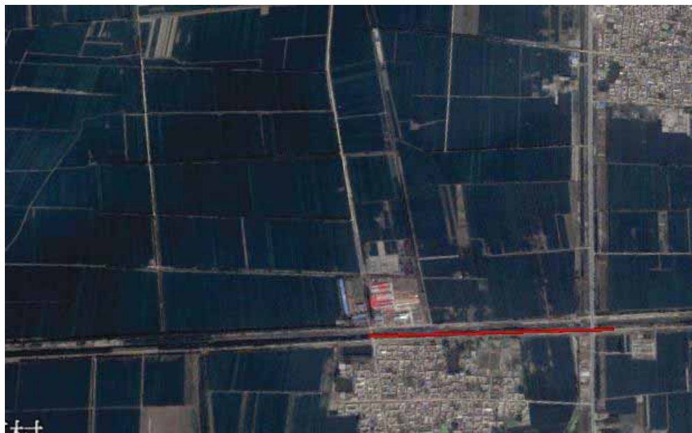
项目建设前遥感影像（2015 年 4 月）
