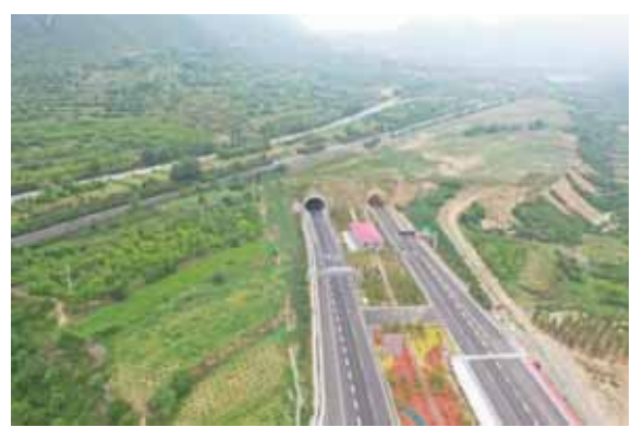
隧道洞口坡面防护、截排水工程、植被恢复
