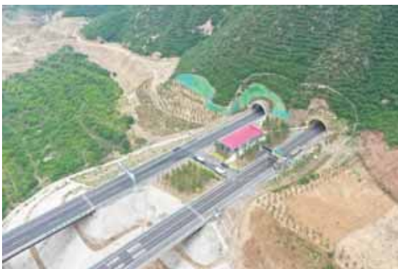
隧道洞口坡面防护、截排水工程、植被恢复
