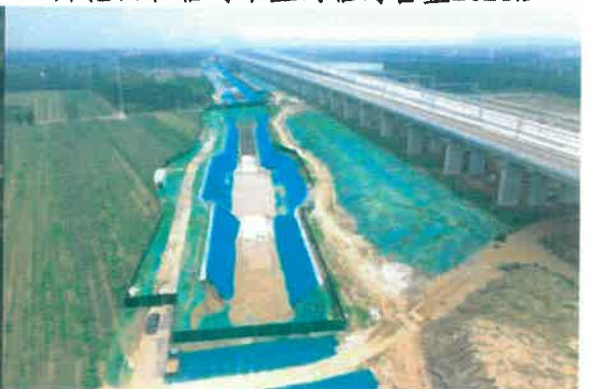
开挖断面苫盖2021.9
