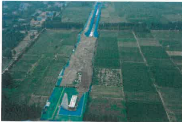
开挖断面苫盖和回填2021.9
