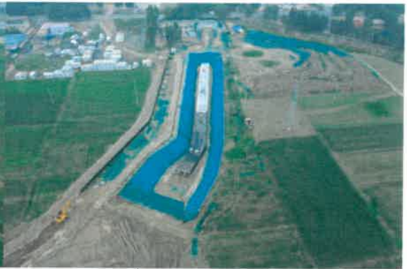
开挖面和临时堆土的临时苫盖2021.9
