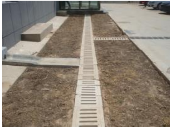
升压站混凝土排水沟
