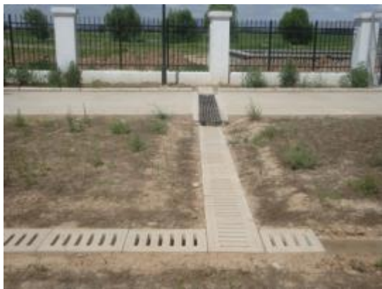
升压站混凝土排水沟
