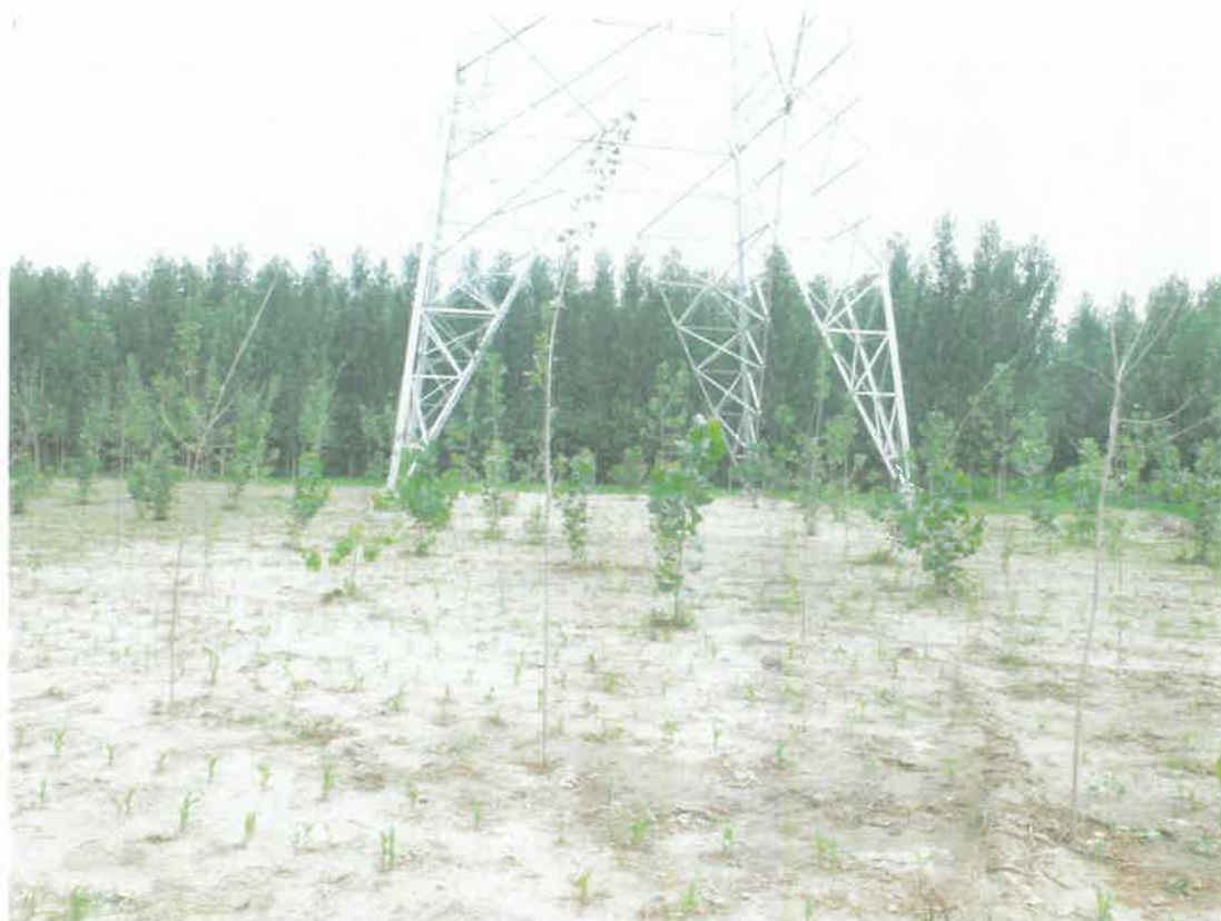
输电线路塔基施工区土地整治
