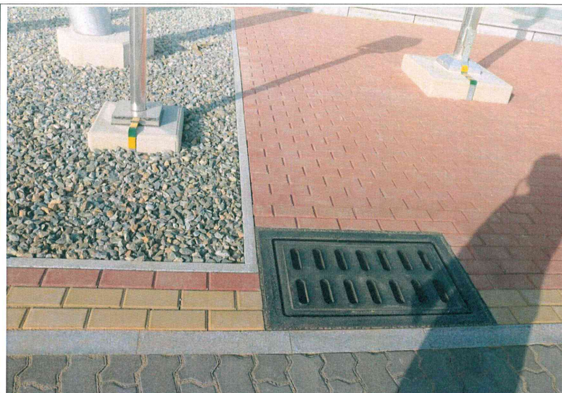
变电站透水砖、碎石子和排水（2019.11）
