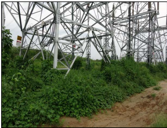
龙常 I、II 回 1 号塔基（2018.8）
