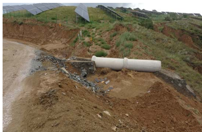
浆砌石排水沟末端铺设管涵
