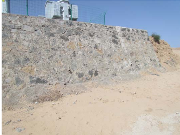
箱变逆变基础浆砌石挡墙
