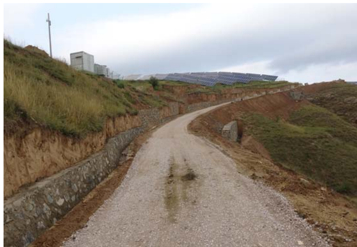
道路修建浆砌石挡墙、排水，路面铺设碎石
