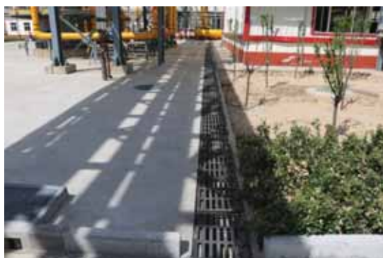
构建筑物区框格护坡、排水沟、种草（2019 年 6 月）
