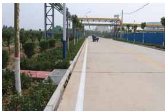
构建筑物区框格护坡、排水沟、种草（2019 年 6 月）
