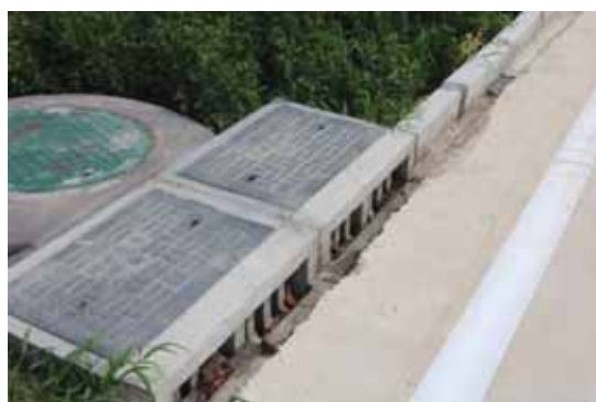
构建筑物区框格护坡、排水沟、种草（2019 年 6 月）
