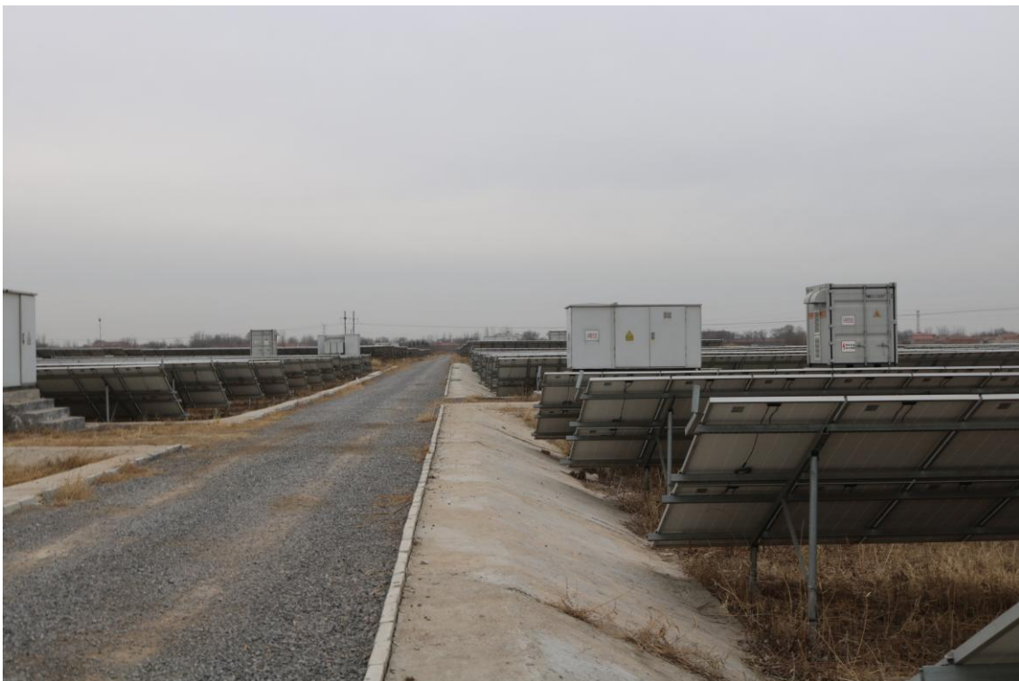
场内道路混凝土护坡
