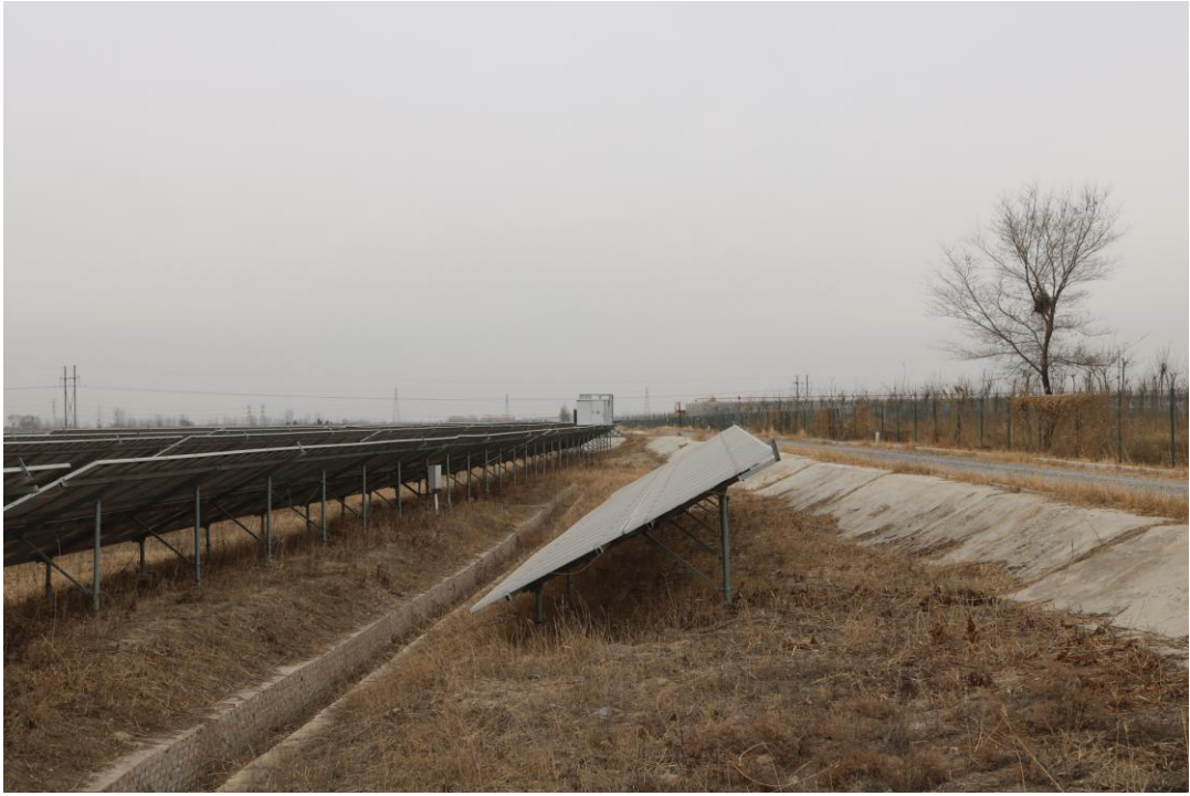
砖砌防洪沟、场内道路护坡
