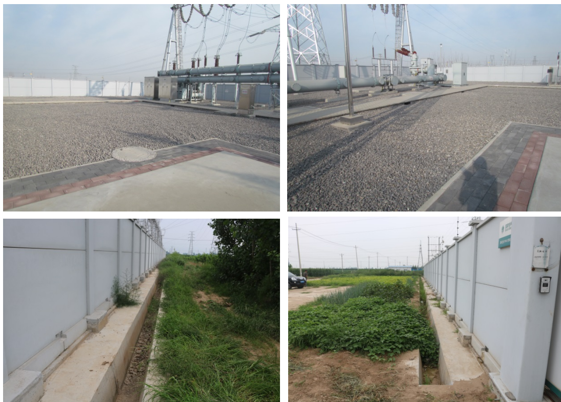
变电站碎石地面及站外混凝土排水沟（2019 年 8 月）
