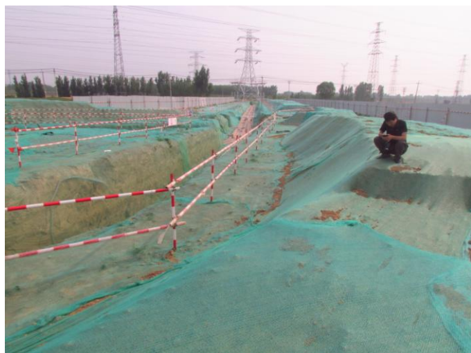
塔基区与电缆施工区临时遮盖 2020.6
