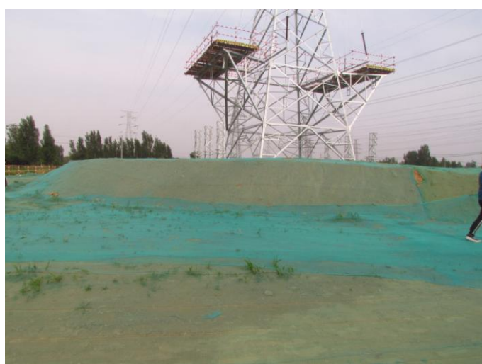
电缆施工区临时遮盖与彩钢板围挡 2020.6
