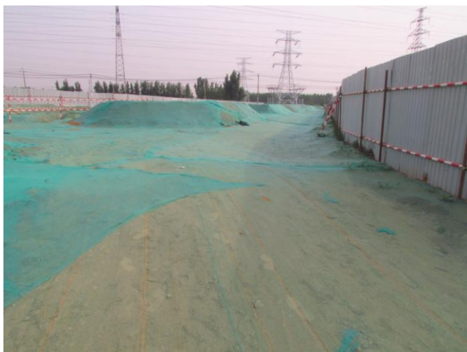
电缆施工区临时遮盖与彩钢板围挡 2020.6
