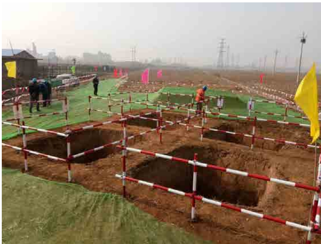
土地整治工程（表土清理）、临时防护工程（临时苦盖）
