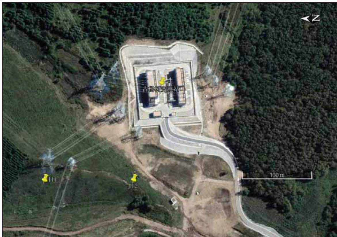
图 2-4 古杨树 220kV 变电站现场影像图
