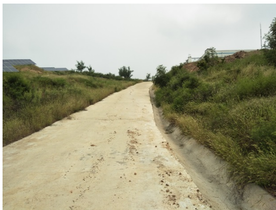
进站道路混凝土排水沟及两侧植被恢复
