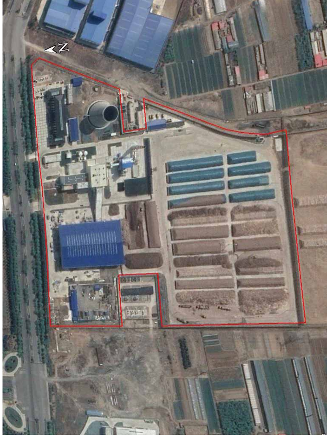
项目施工完工遥感影像（2020.4.29）
