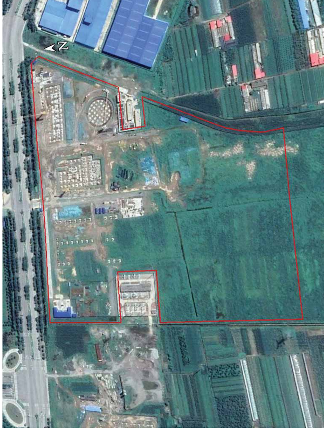
项目施工期遥感影像（2018.7.27）
