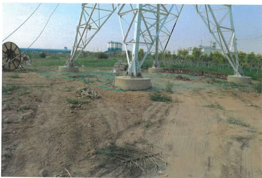
57 号塔临时防护工程（防尘网遮盖）
