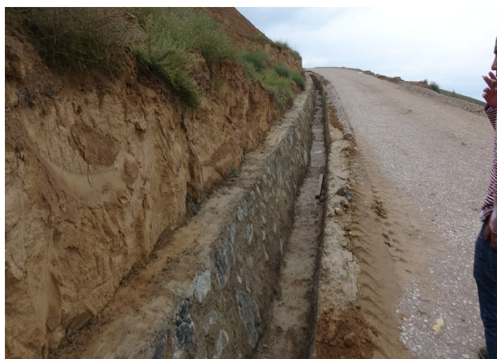
道路浆砌石挡墙结合浆砌石排水
