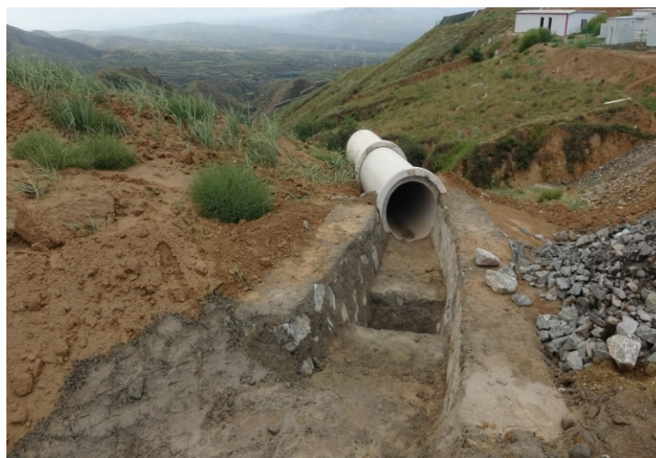
排水沟末端管涵和沉砂池
