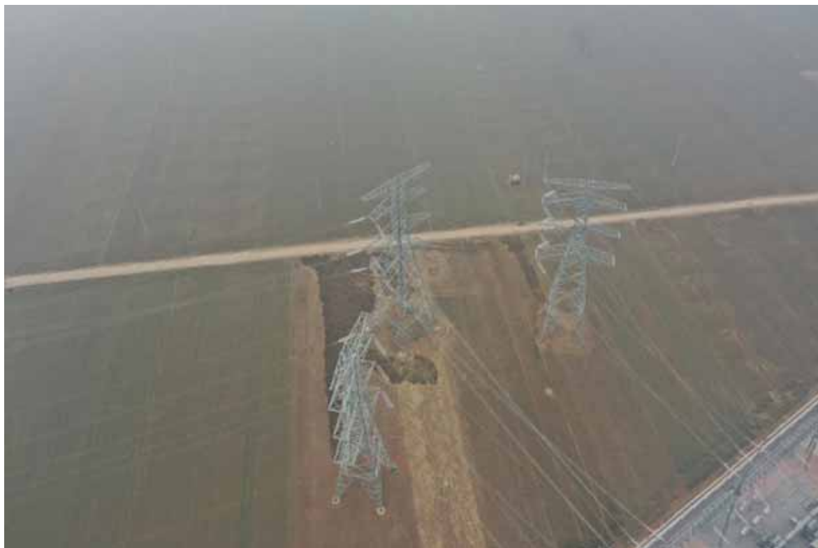
塔基区土地整治（起点平乡变电站，2022.1）
