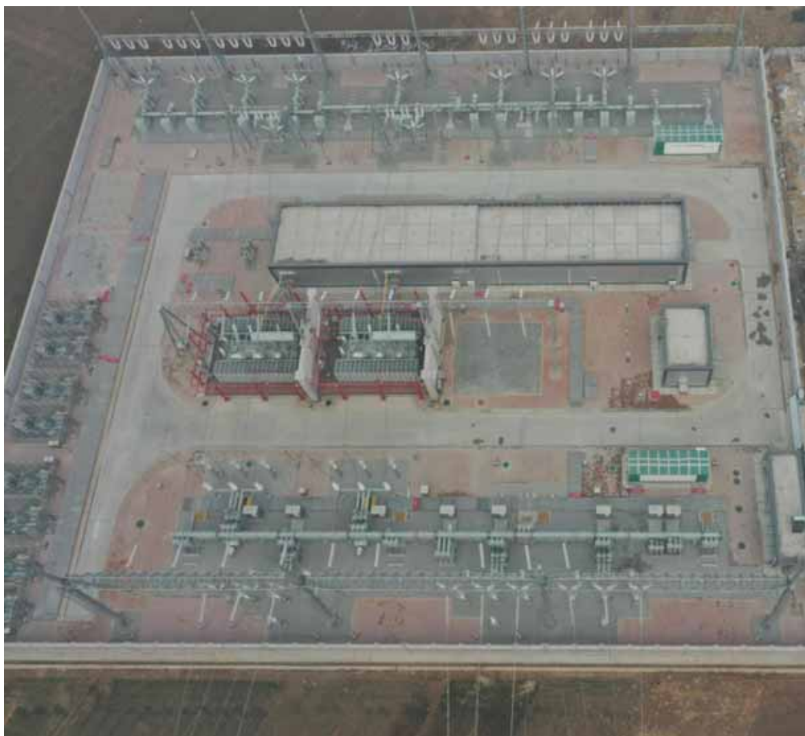
变电站碎石覆盖、透水砖铺设（2021.11）
