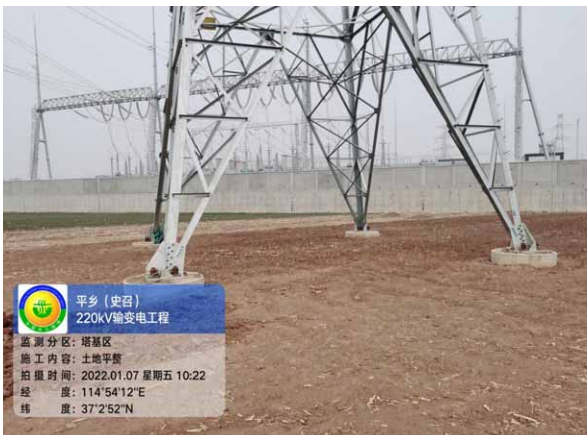
塔基区土地整治（起点平乡变电站，2022.1）
