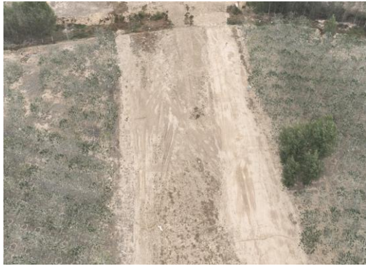
隧道明挖工程区基础平整2022.10
