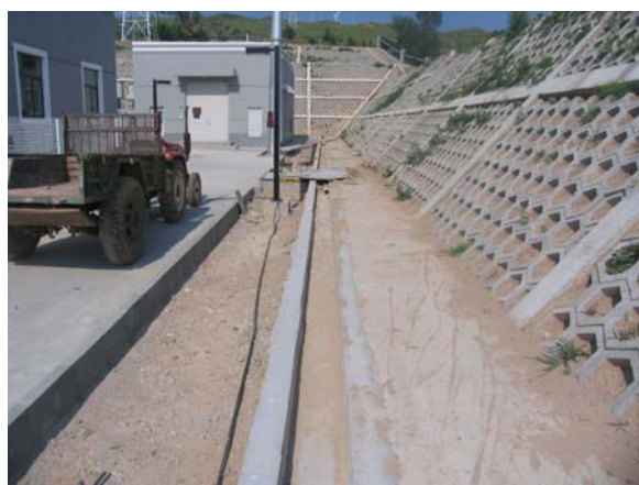
110kV 变电站六棱砖护坡(2016 年 7 月)
