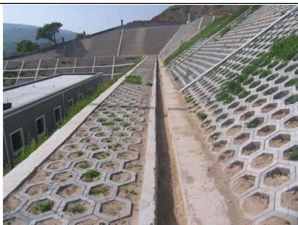
110kV 变电站排水沟(2016 年 7 月)
