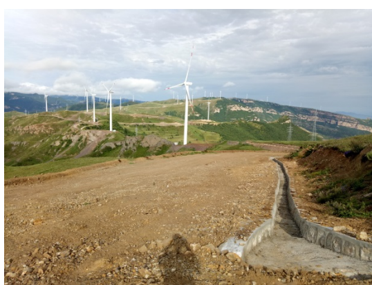
施工检修道路边坡防护及排水
