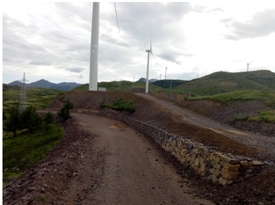
施工检修道路边坡防护及排水
