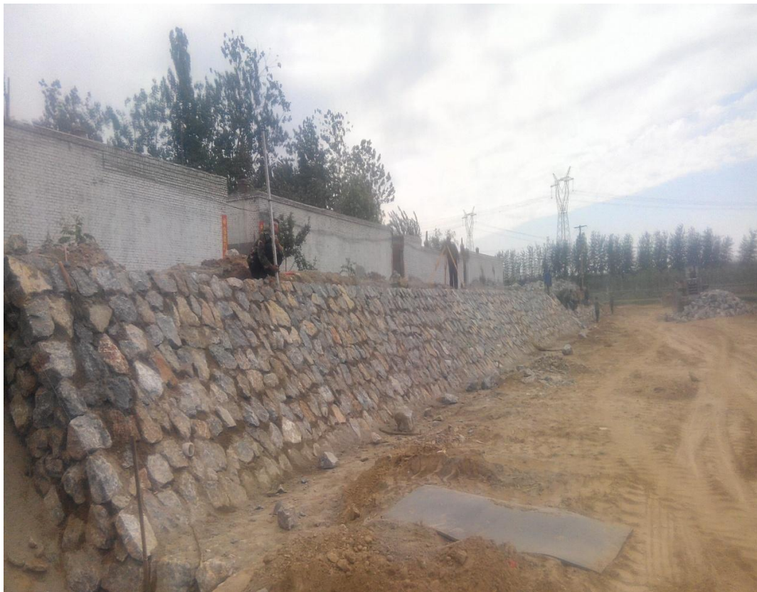
2017年5月 许固坡水区浆砌石筑砌
