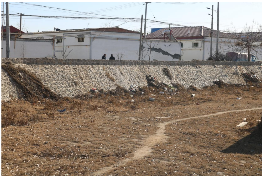
2019年12月许固坡水区浆砌石护坡
