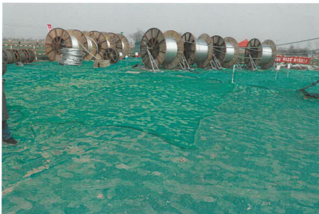
输电线路架线施工中
