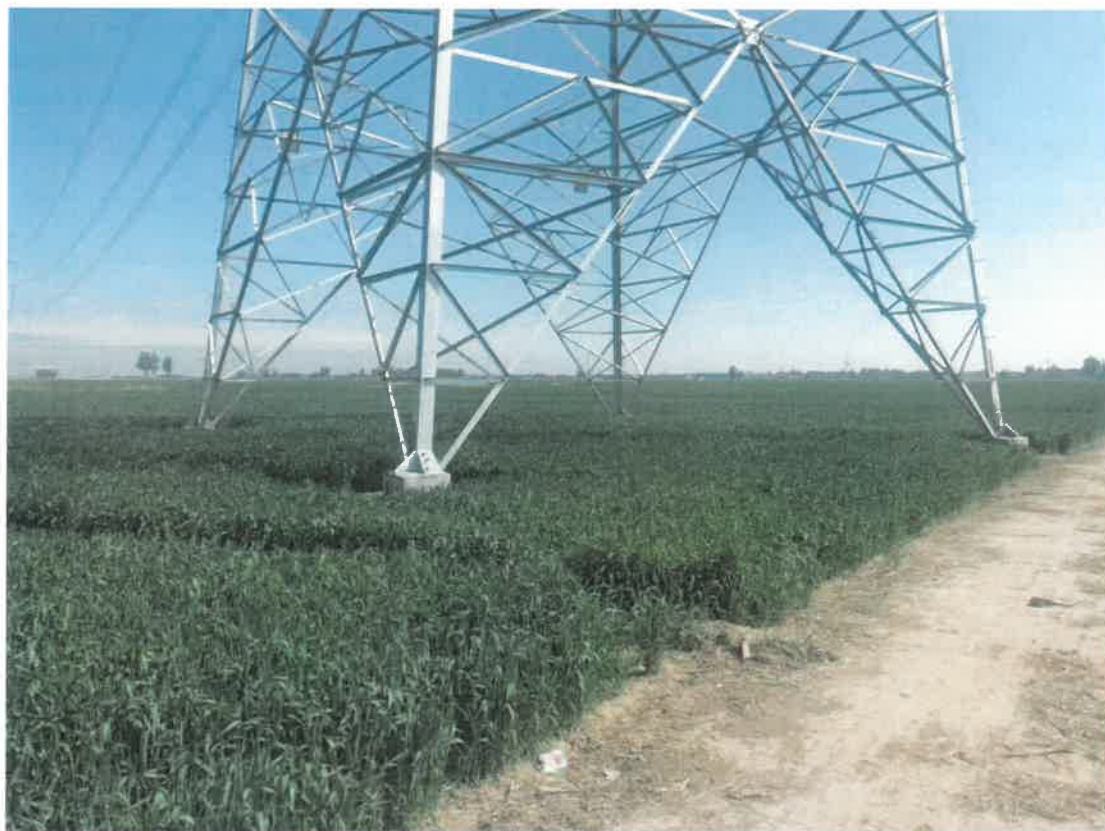
输电线路塔基施工完毕
