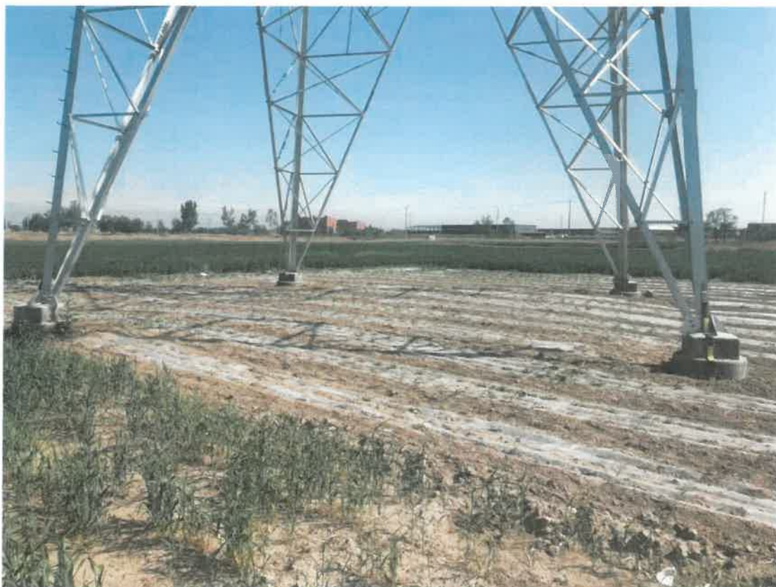
输电线路塔基施工完毕
