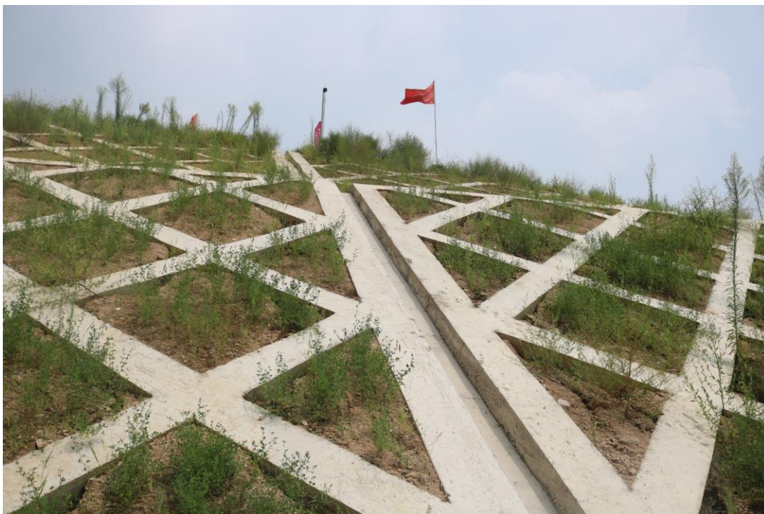
变电站框格护坡
