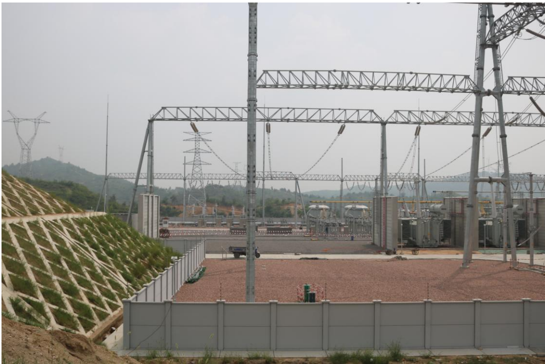
变电站铺碎石、站外框格护坡
