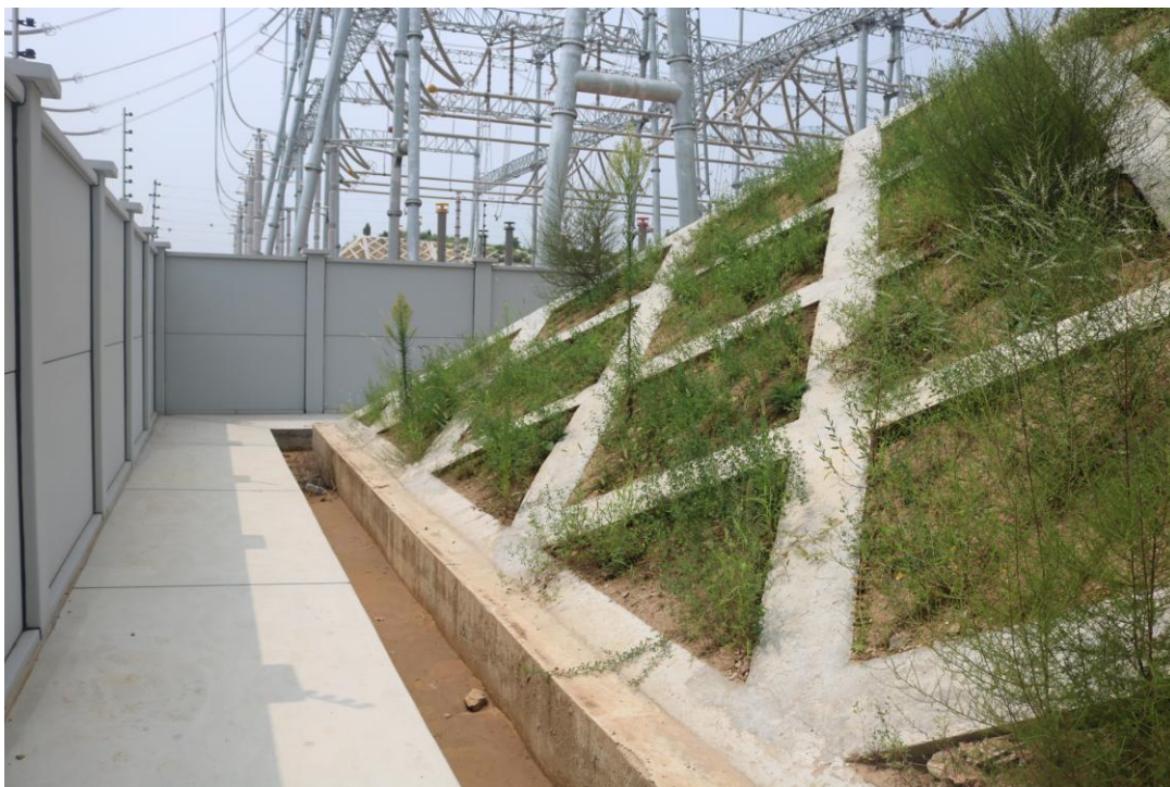
变电站框格护坡
