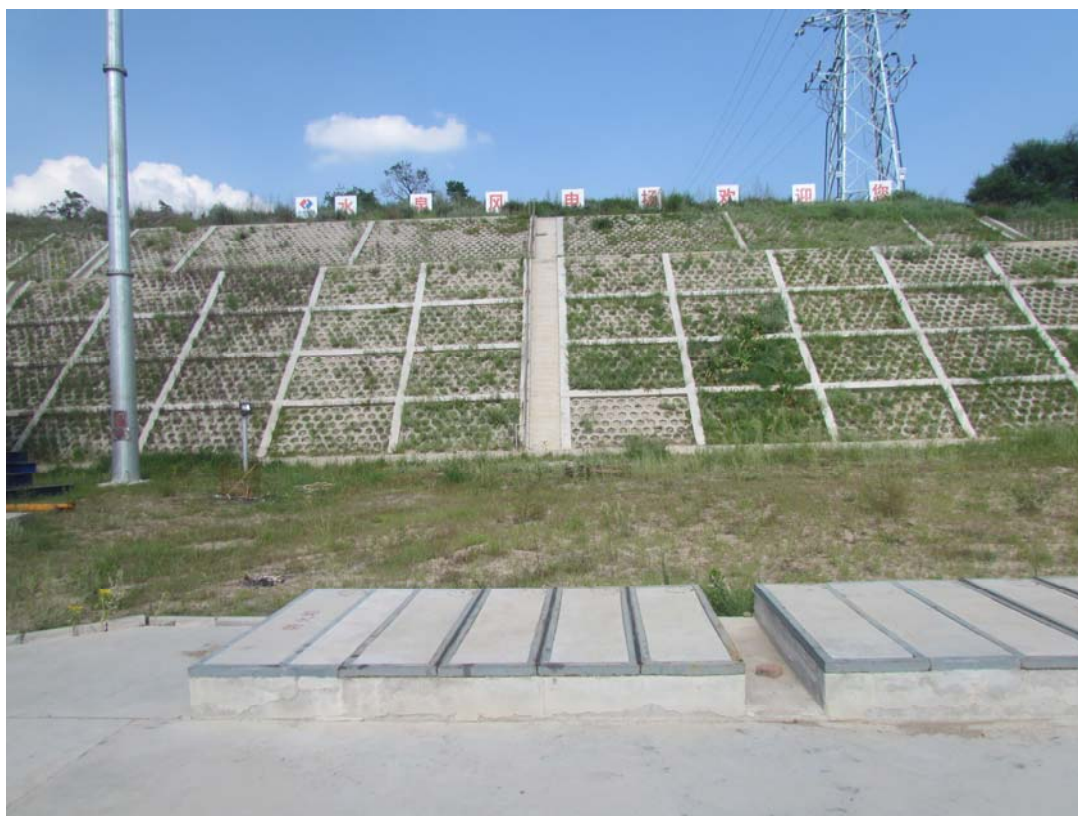
110kV 升压站六棱砖护坡及截排水沟
