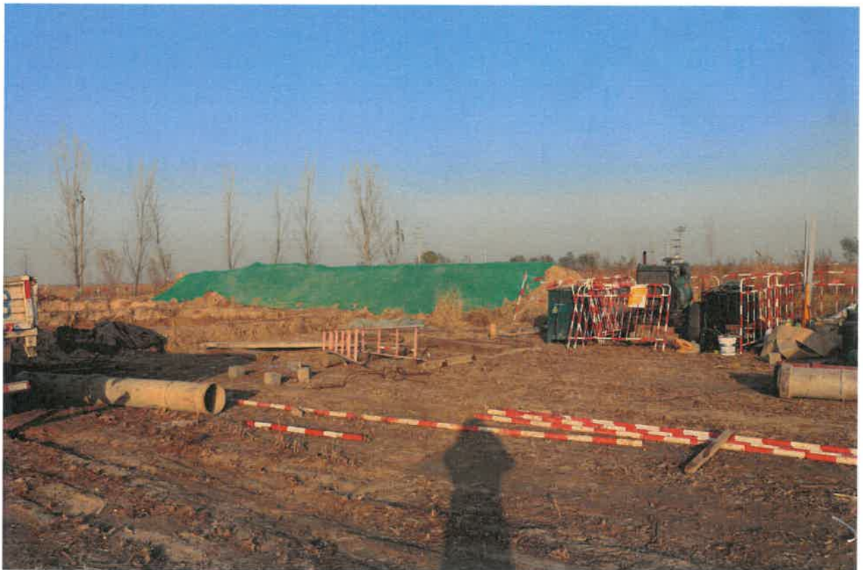
塔基区临时遮盖
