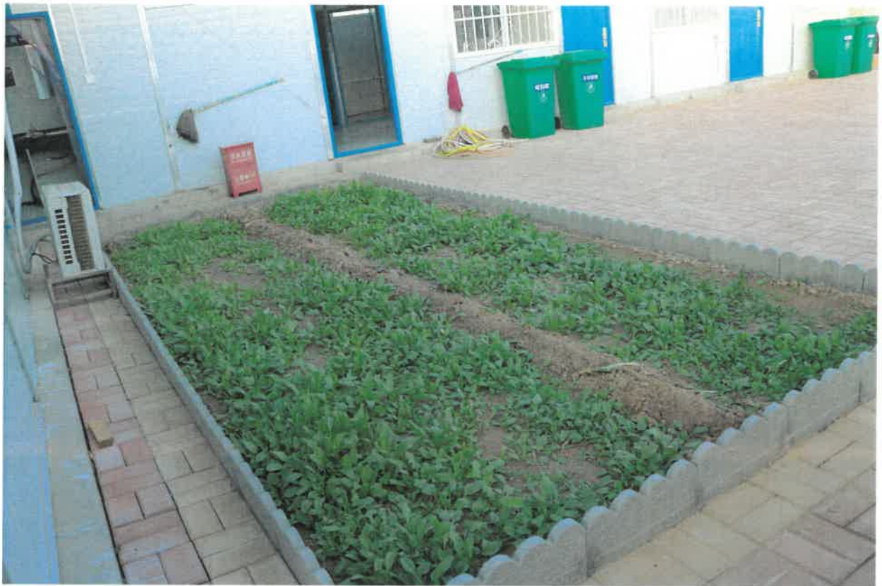
施工生产生活区透水砖和临时绿化
