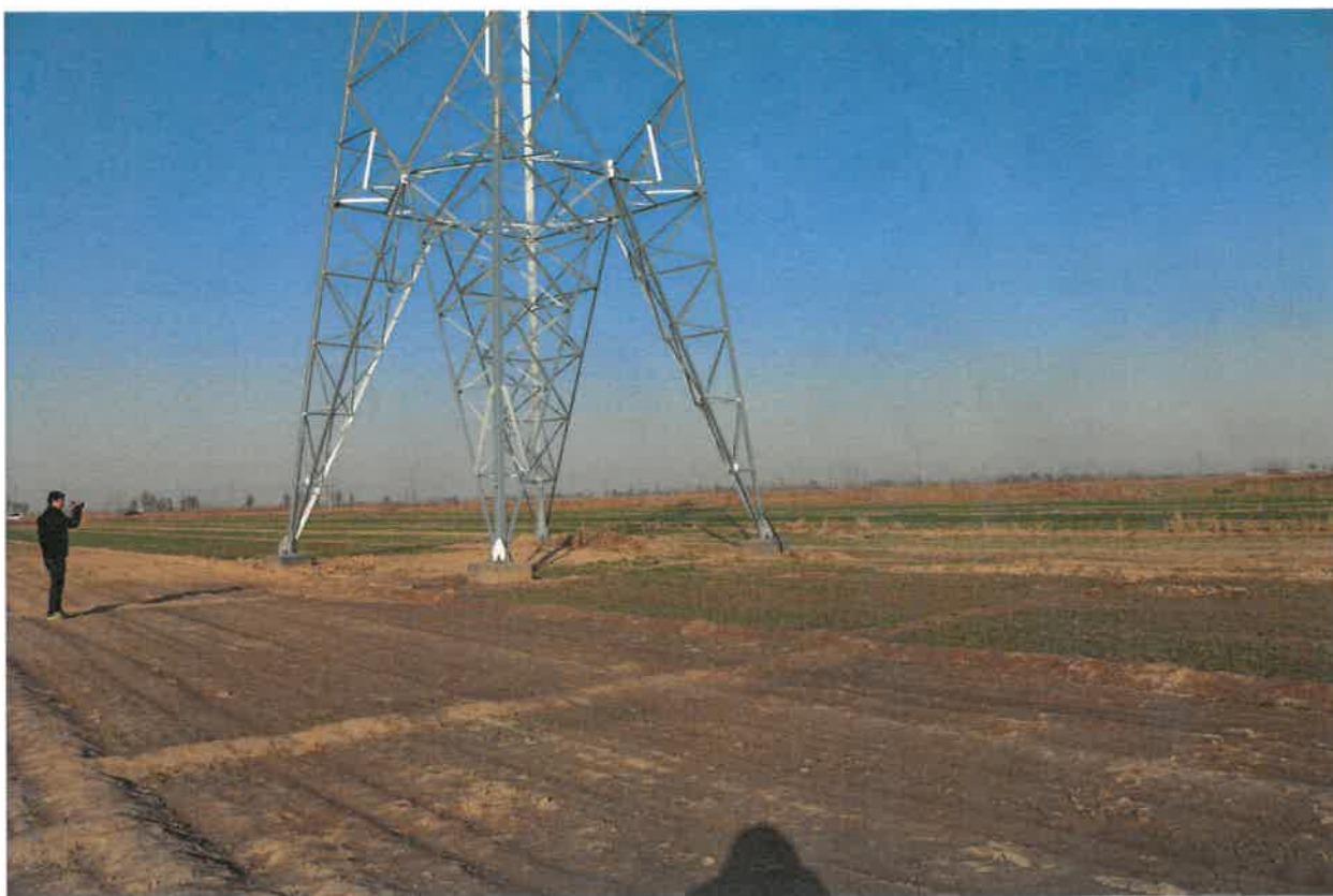
塔基区及施工便道整地
