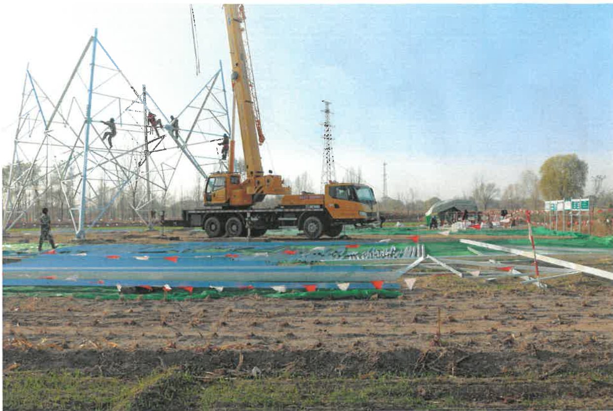
塔基区临时遮盖
