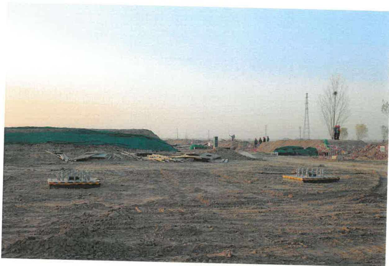
变电站临时遮盖
