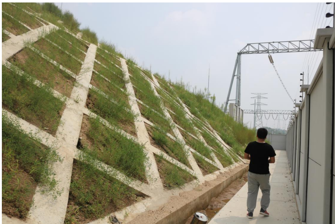
变电站框格护坡（2018年8月2日）
