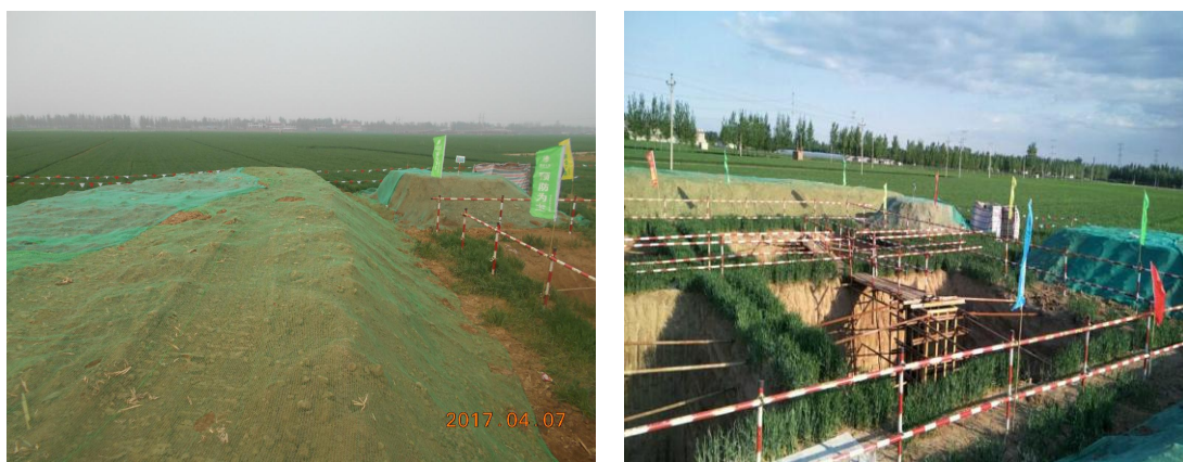
图 4-4 邢西—彭村 500kV 线路工程临时遮盖措施
