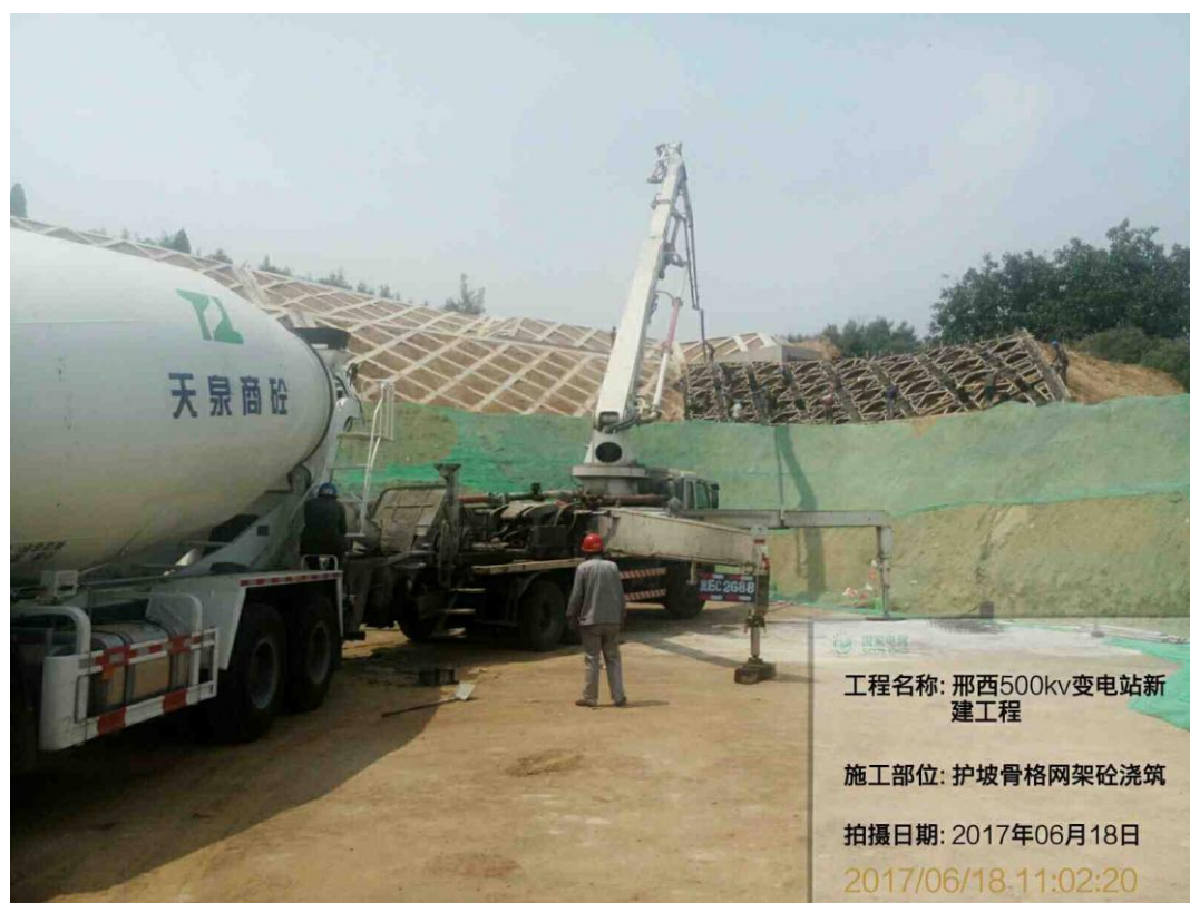
变电站框格护坡（2017年6月18日）
