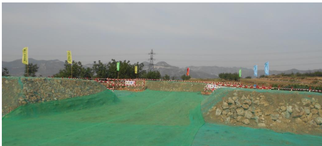
图 4-3 邢西一涉武 500kV 线路工程临时遮盖措施
