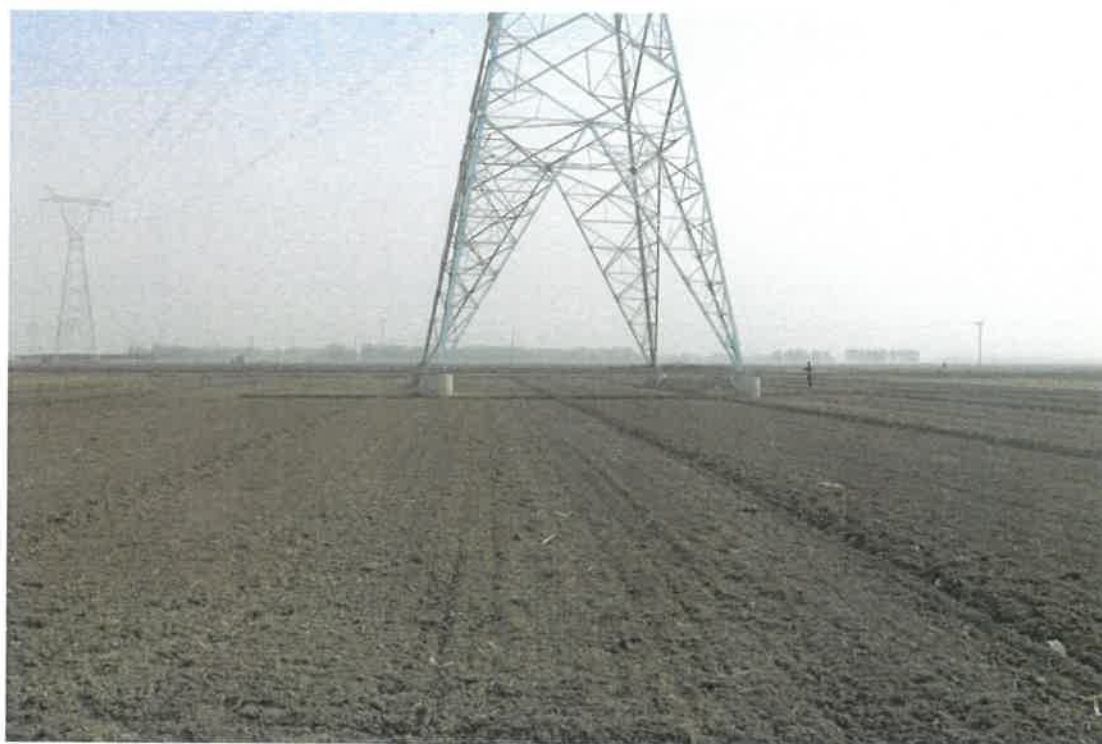
塔基施工区完成整地
