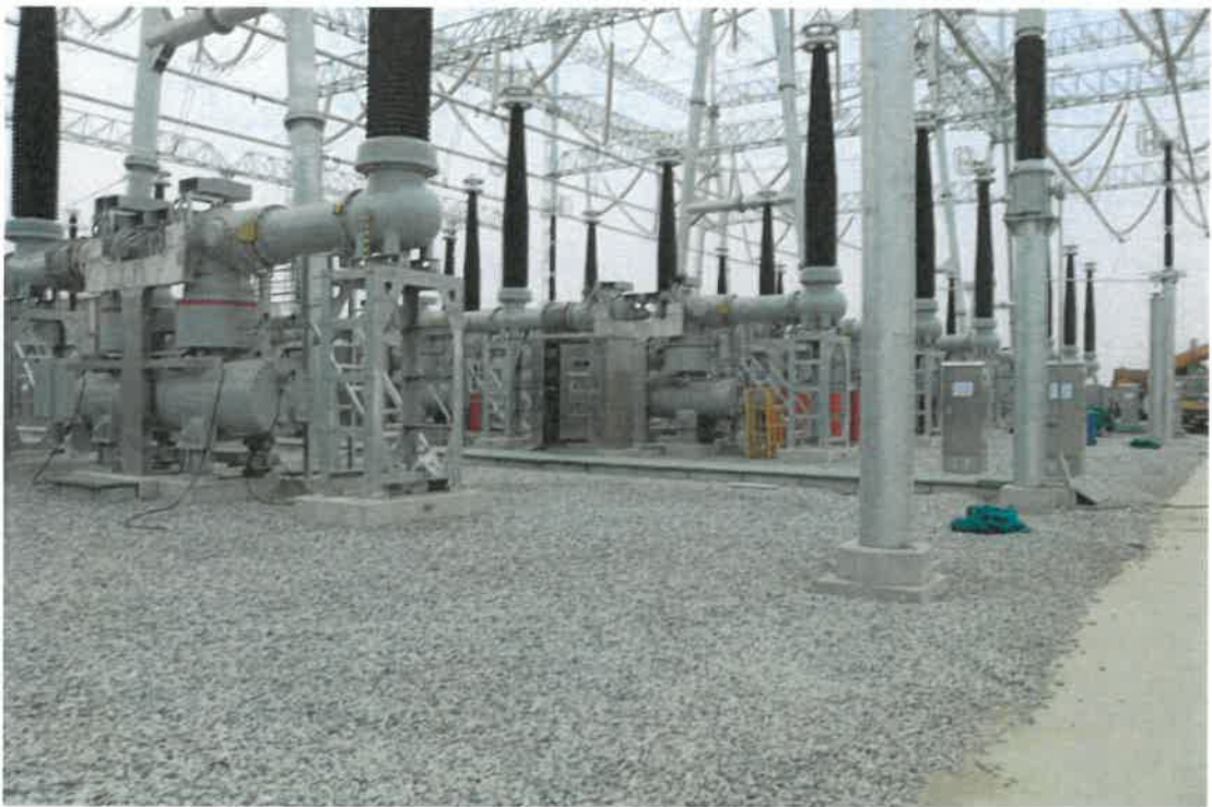
变电站铺设碎石
