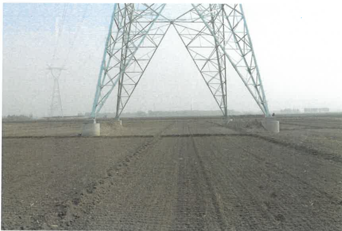
线路塔基区表土回铺完毕
