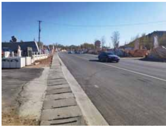
改建路基区盖板排水沟及两侧绿化
