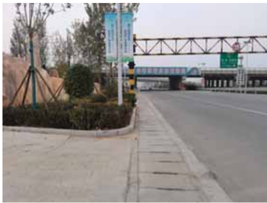
改建路基区盖板排水沟及两侧绿化
