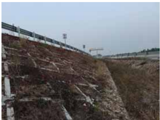
新建路基框格植草护坡、梯形排水沟、泄水槽及园林绿化
