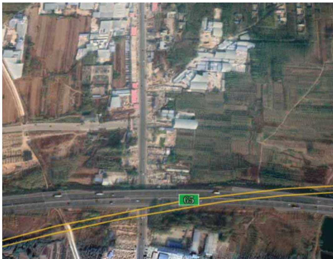
项目建设前（2018 年 11 月）
