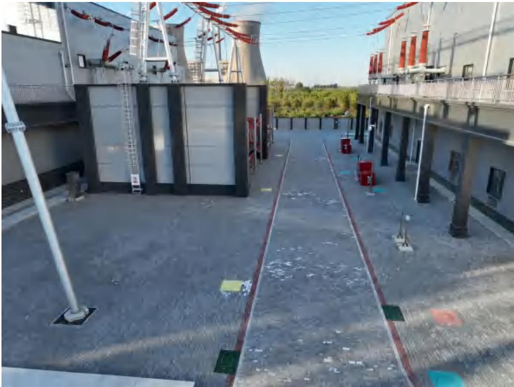
变电站透水砖及雨水收集口(2022.10.10)
