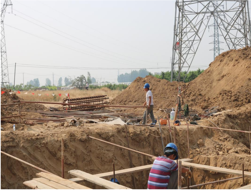
基础开挖表土放置最外层
