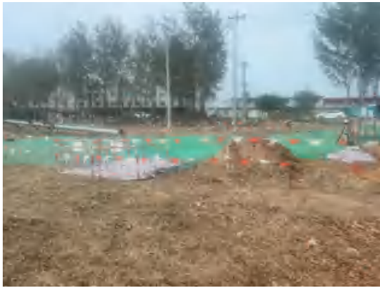
塔基施工区临时遮盖
