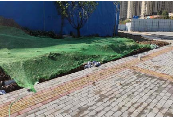
施工中临时苫盖及彩钢板围挡、透水砖
