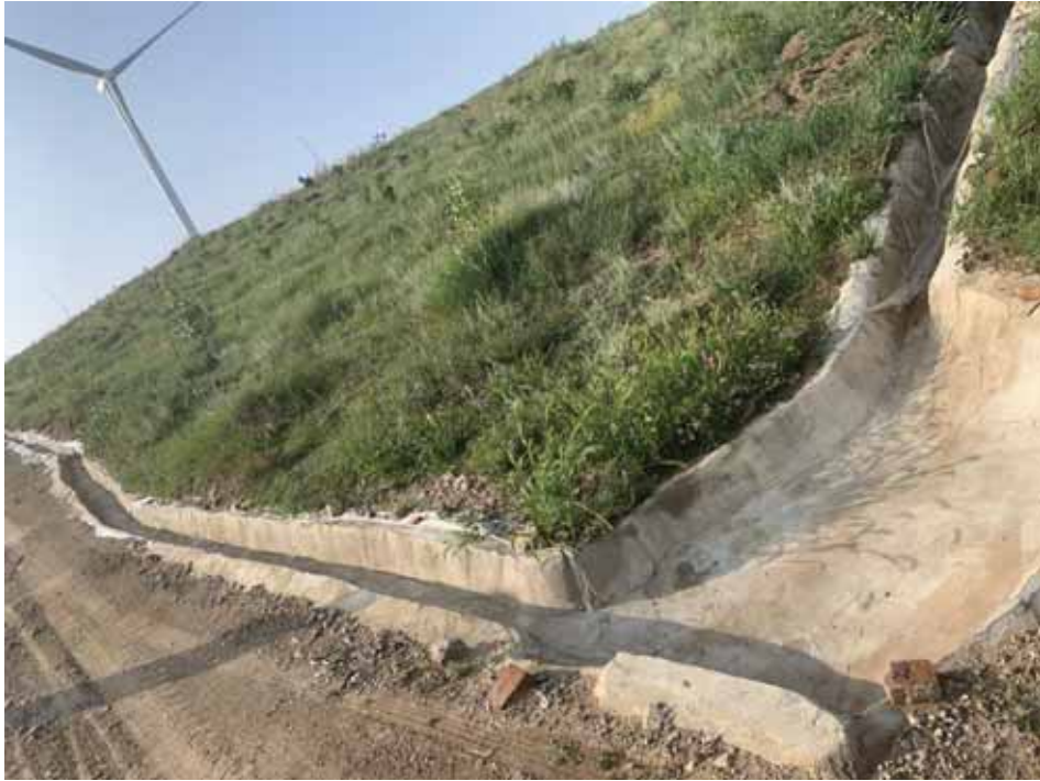
施工检修道路排水沟
