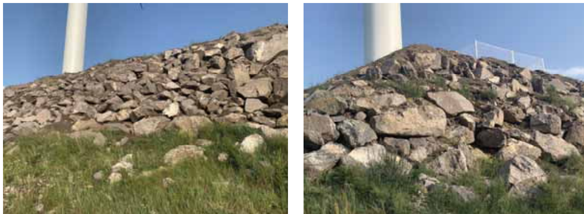
附图 6-2 风机区干砌石护坡
