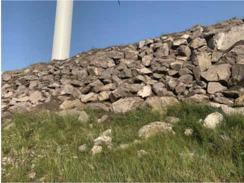
风机区干砌石护坡
