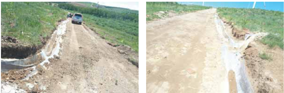
附图 6-1 施工检修道路混凝土排水沟
