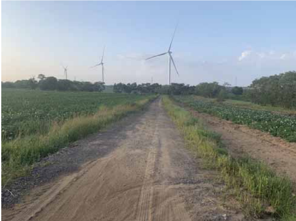
施工检修道路种草
