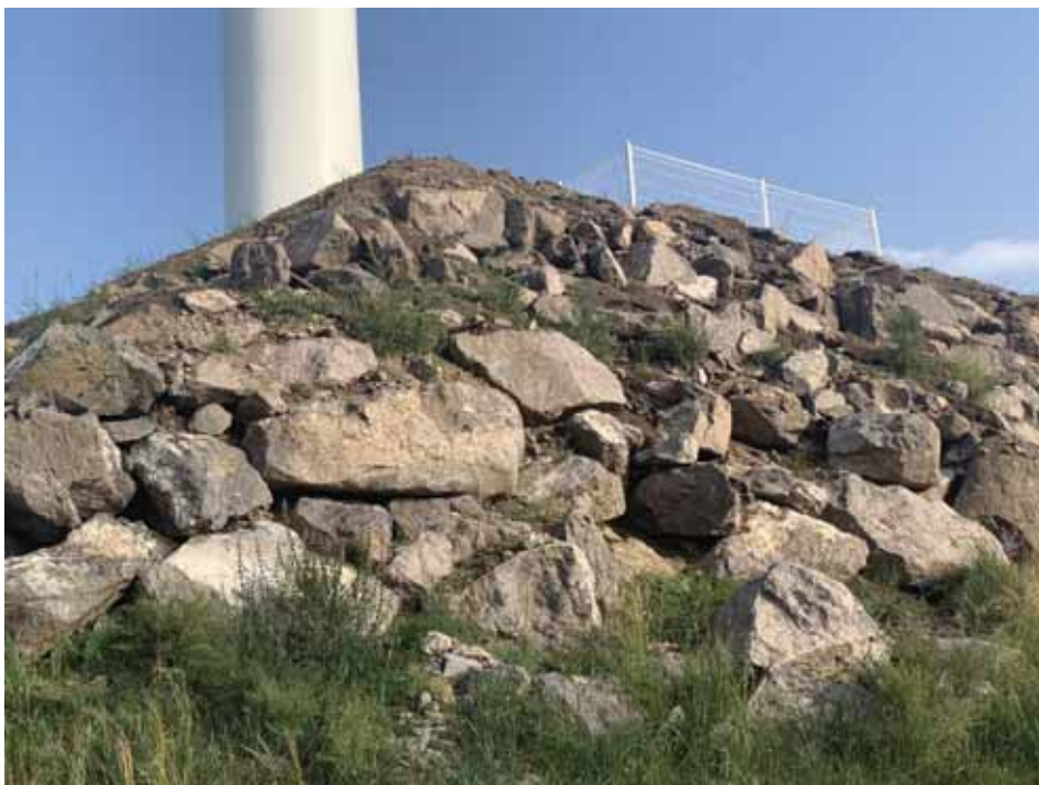
风机区干砌石护坡
