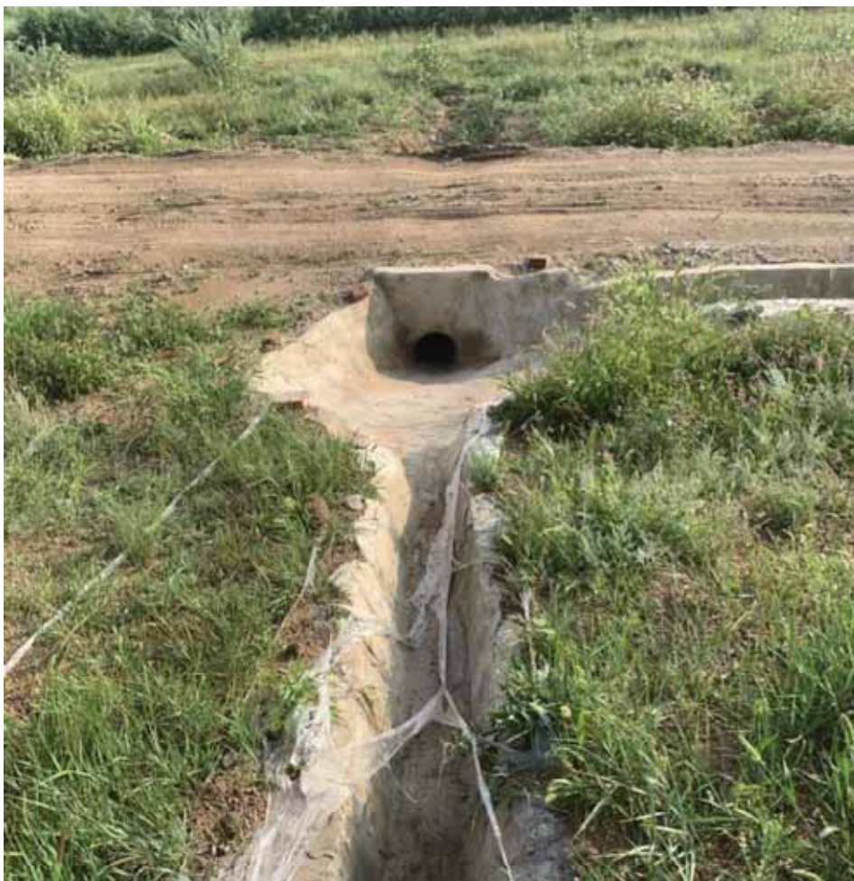
施工检修道路排水沟
