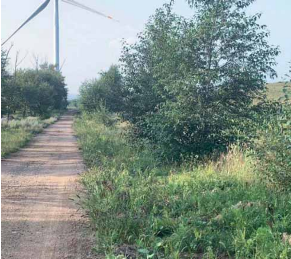
施工检修道路种草
