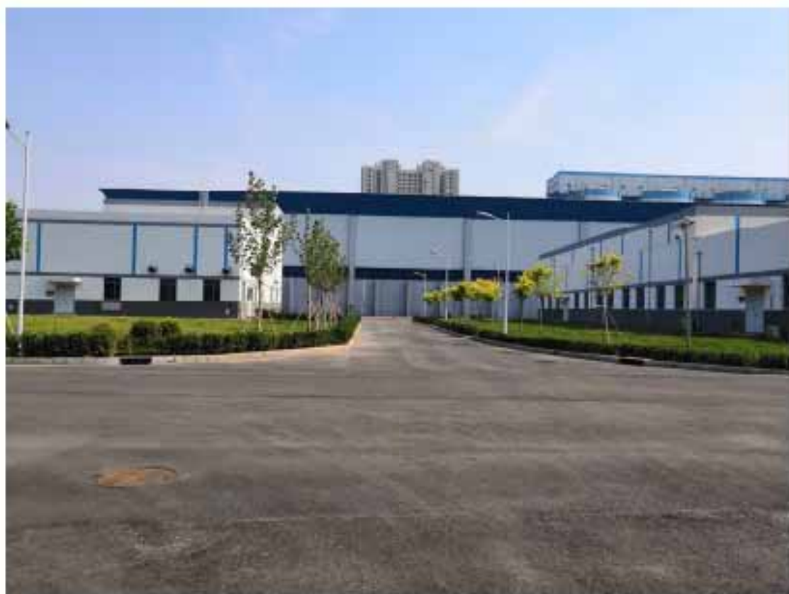
厂区雨水排水管道及绿化
