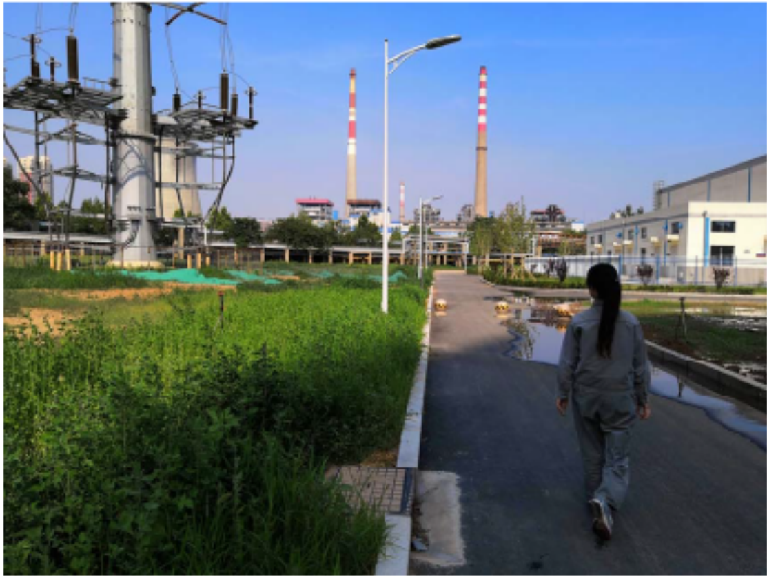
厂区雨水排水管道及绿化
