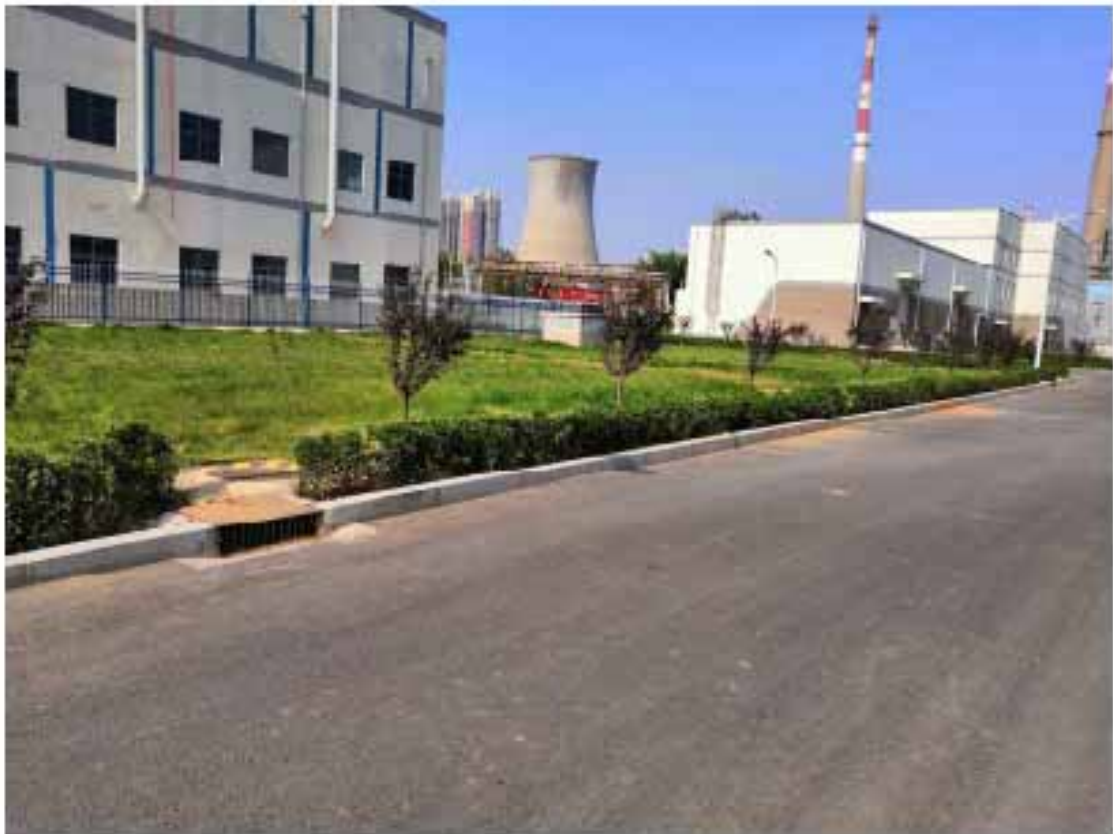
厂区雨水排水管道及绿化
