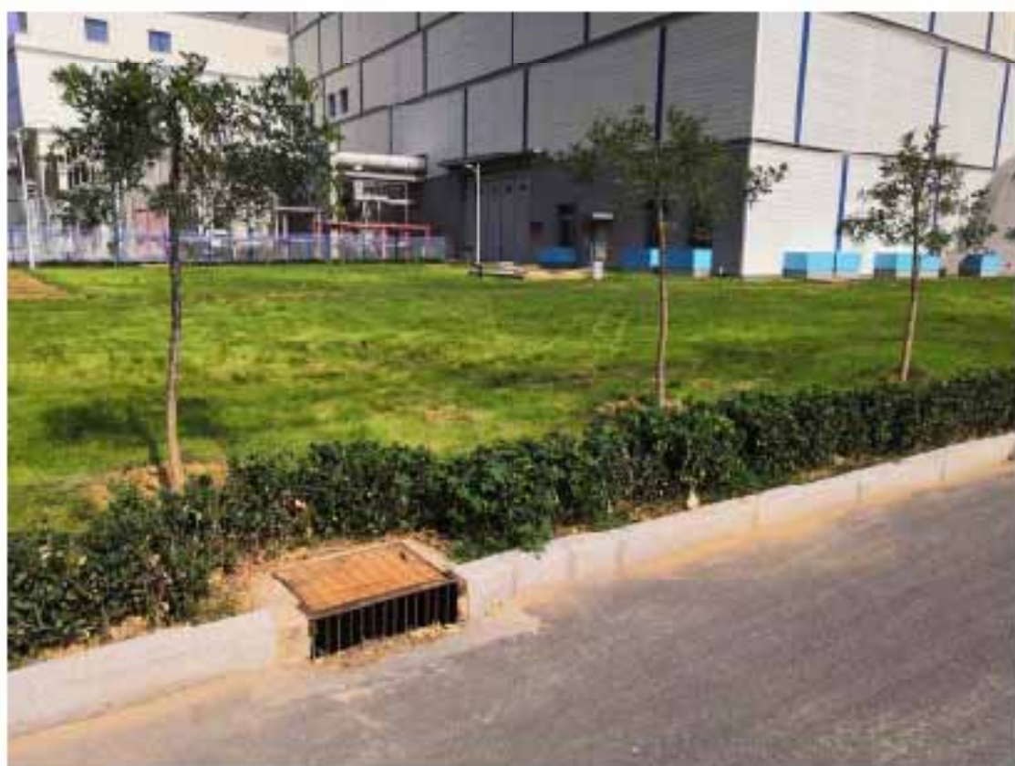
厂区雨水排水管道及绿化
