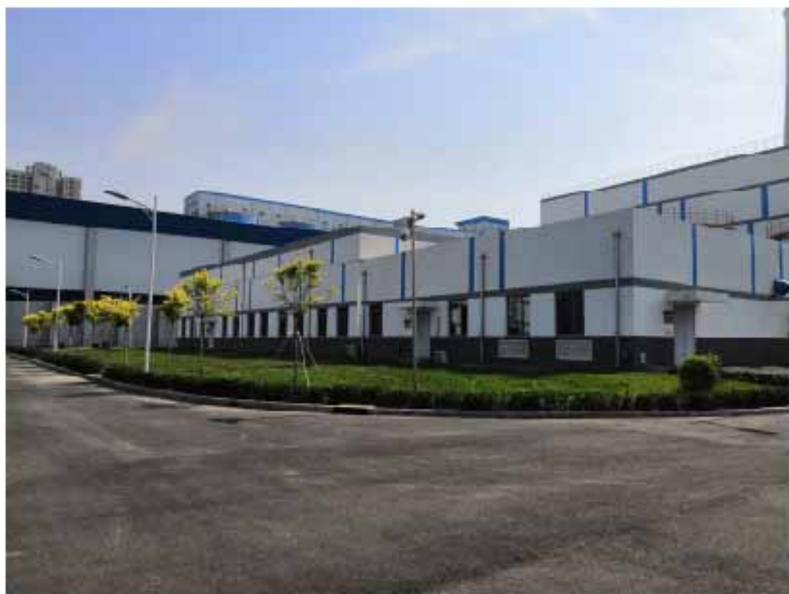
厂区雨水排水管道及绿化
