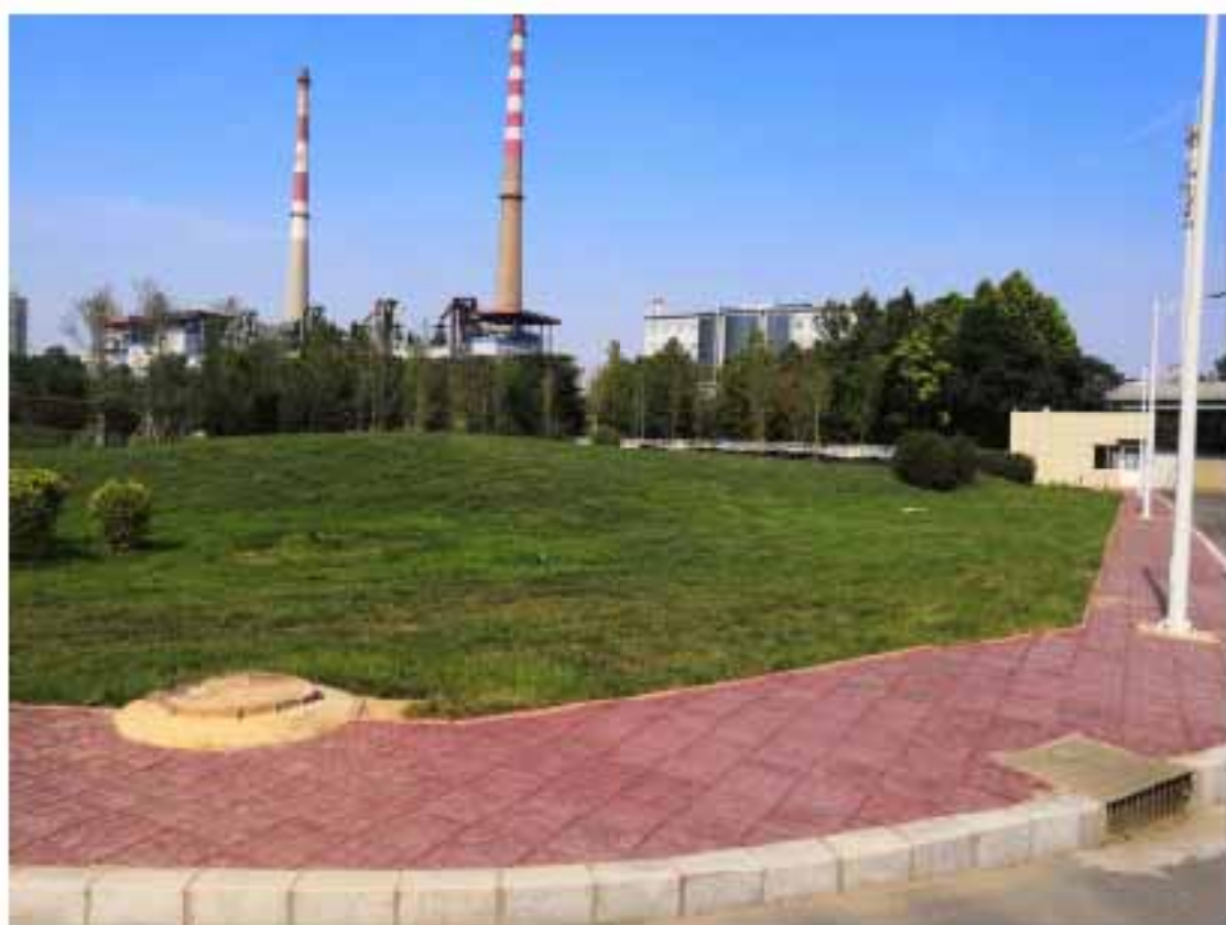
厂区雨水排水管道及绿化
