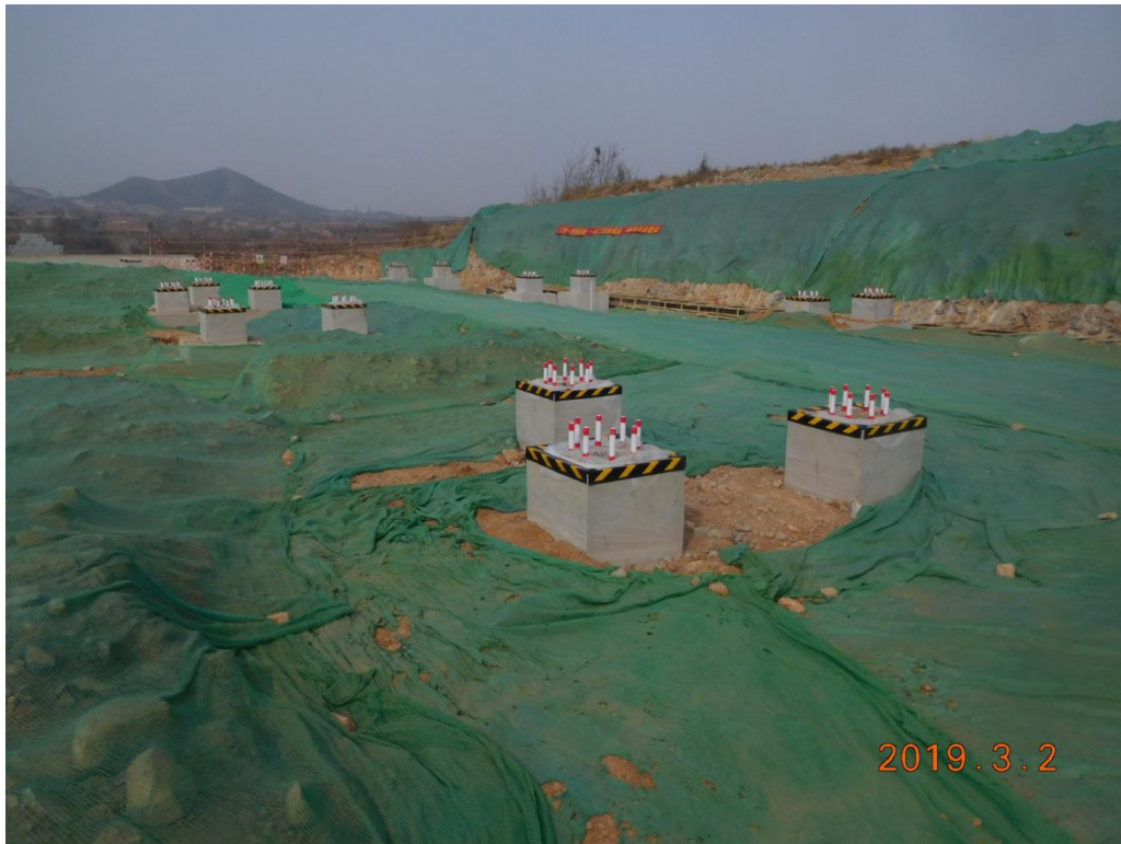
变电站临时防护工程（纱网遮盖）
