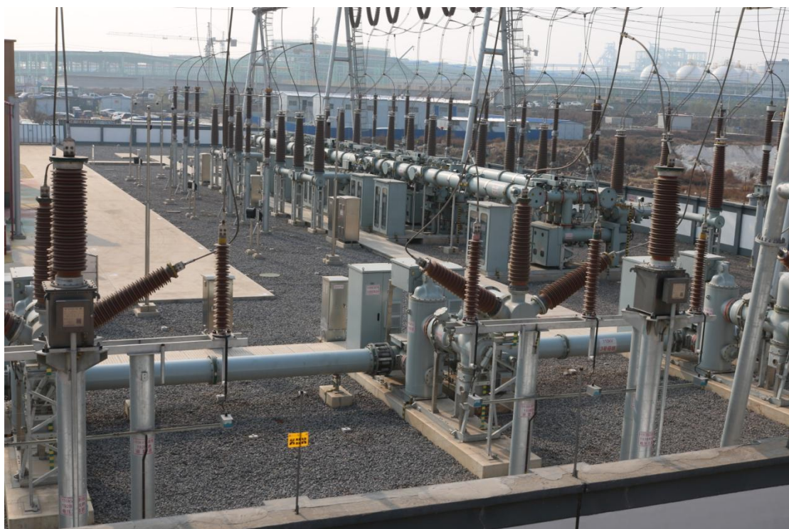
变电站降水蓄渗工程（碎石覆盖）2020.11
