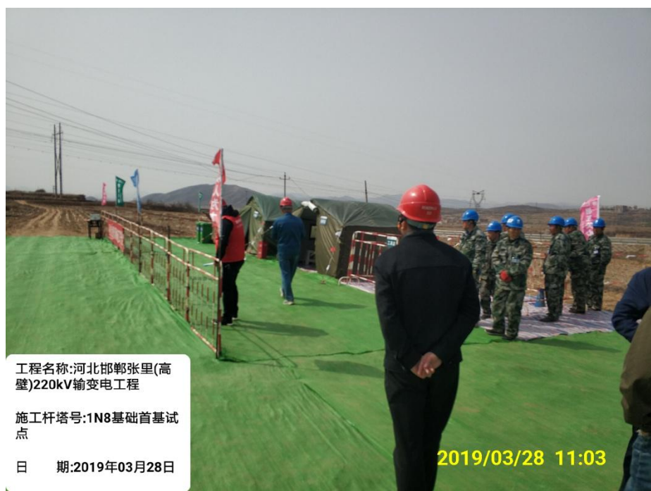
塔基及临时道路临时防护工程（纱网遮盖、彩条布铺垫）
