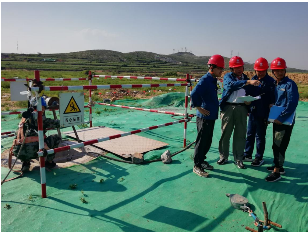
塔基及施工区临时防护工程（纱网遮盖）
