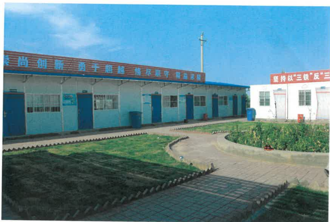
施工生产生活区临时绿化
