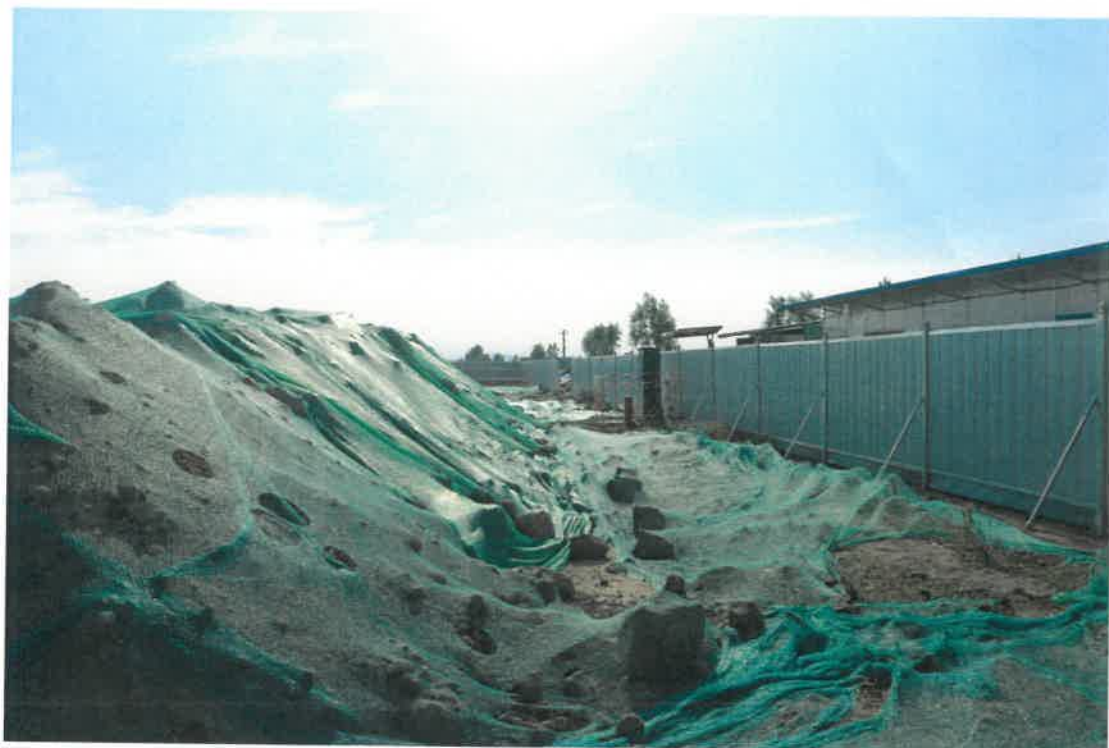
变电站表土清理
