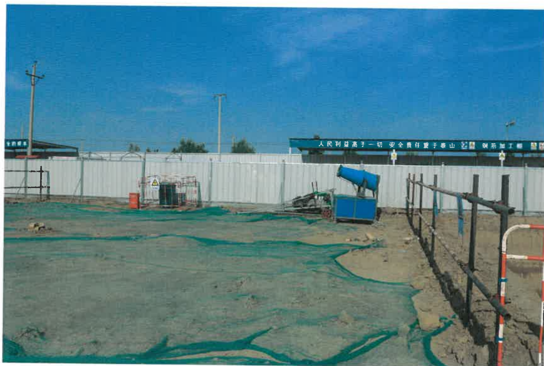
变电站临时遮盖
