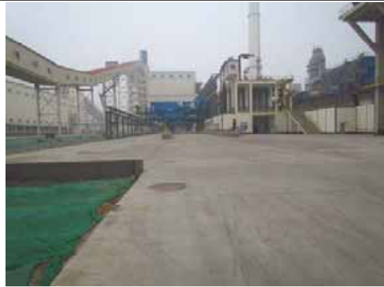
建构筑物区场地硬化
