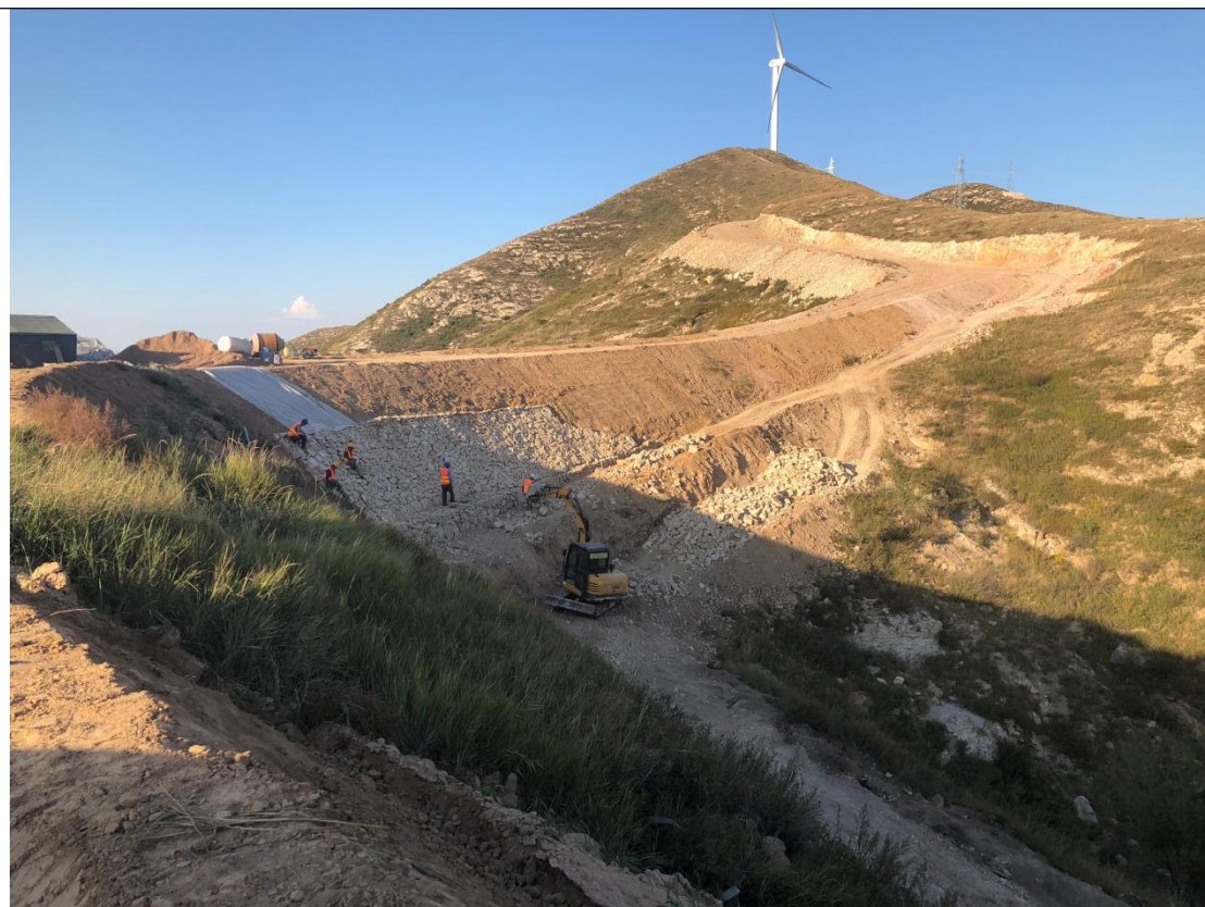
2019 年监测小组现场监测（浆砌石护坡施工中）
