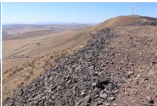
风机区下边坡碎石散落
