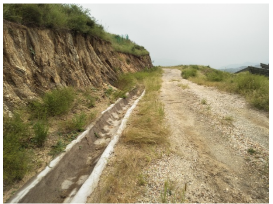
施工检修道路混凝土排水沟
