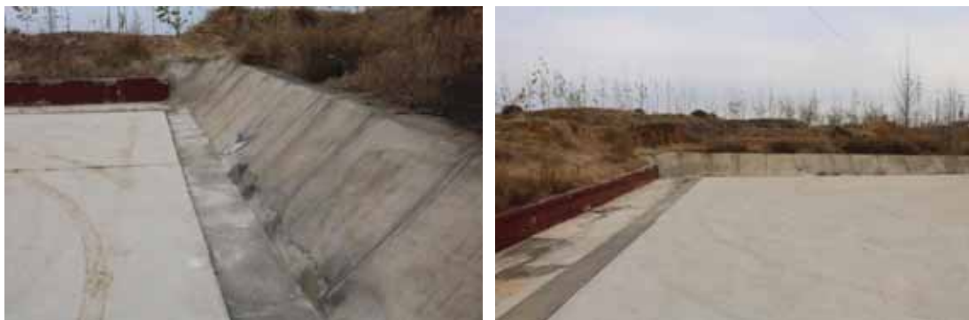
进站道路混凝土护坡、排水沟
