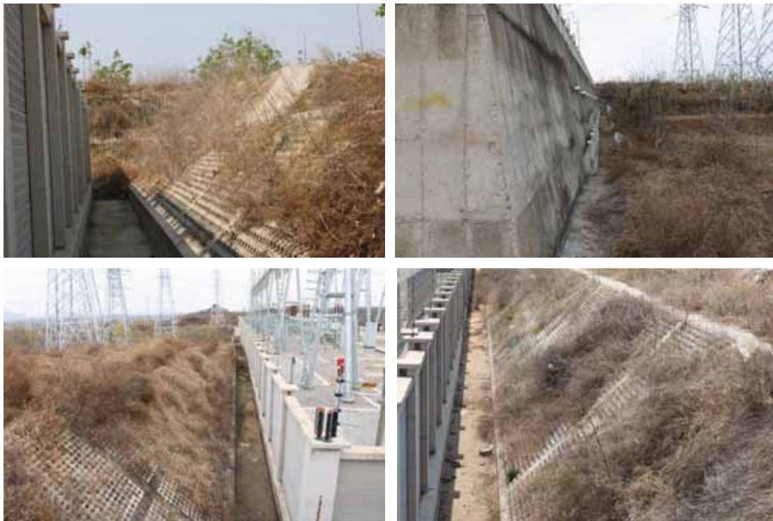
变电站外植草砖护坡、混凝土排水沟
