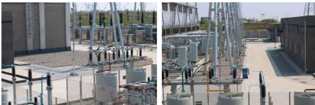
变电站内铺碎石、透水砖
