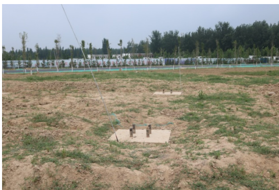
宗东38号基础平整回填 (2018.6)
