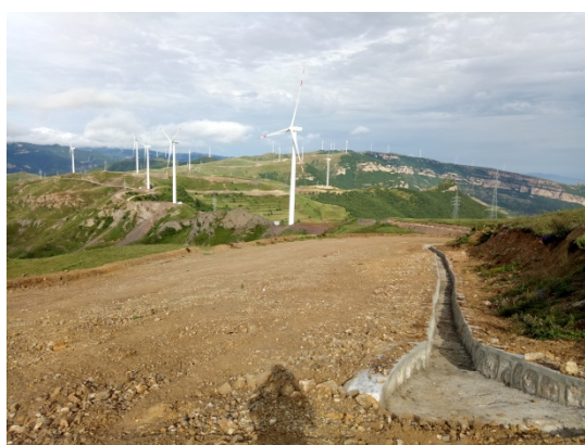
施工检修道路边坡防护及排水
