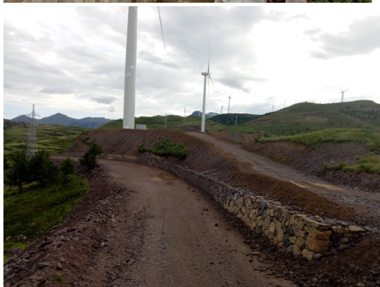
施工检修道路边坡防护及排水
