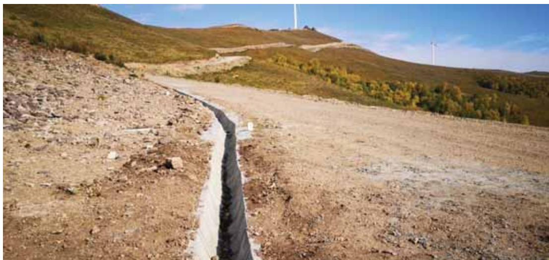
施工道路 U 型槽排水沟
