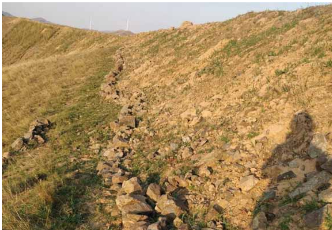
施工道路边坡绿化及路基坡脚拦挡
