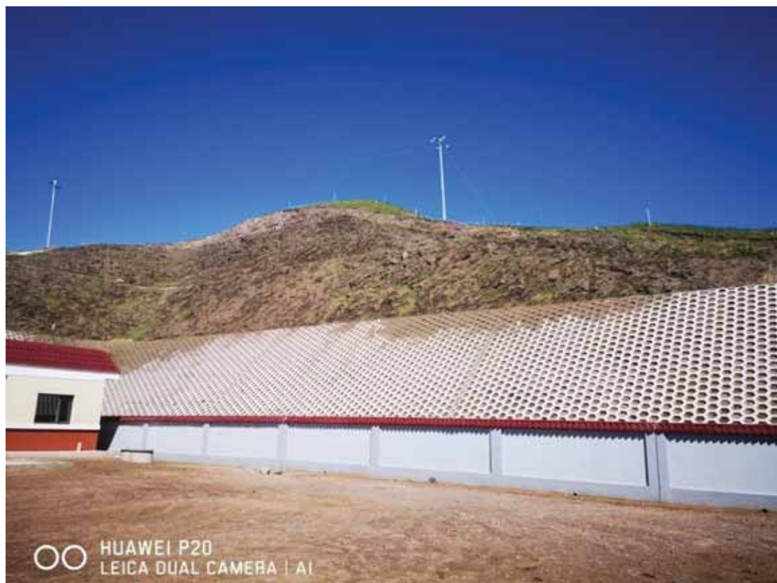
升压站六棱砖护坡及喷播植草
