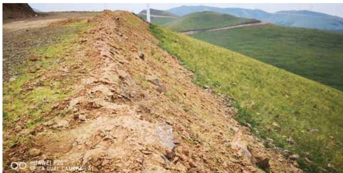
施工道路绿化
