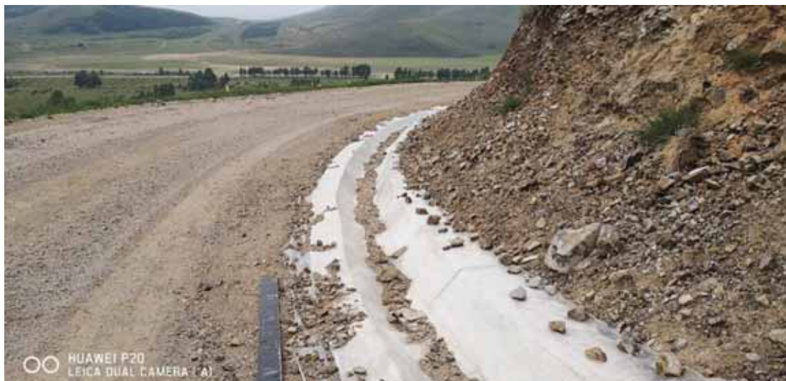
施工道路混凝土排水沟
