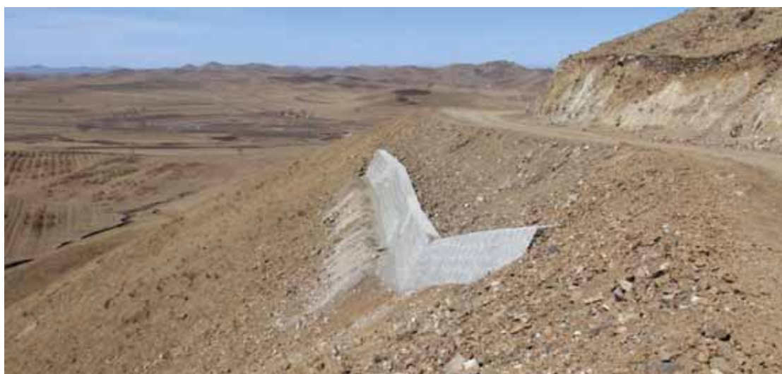
施工道路浆砌石挡墙
