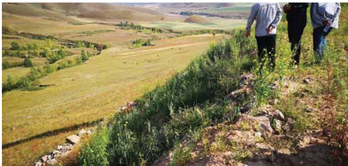
风机区吊装场边坡干砌石拦挡
