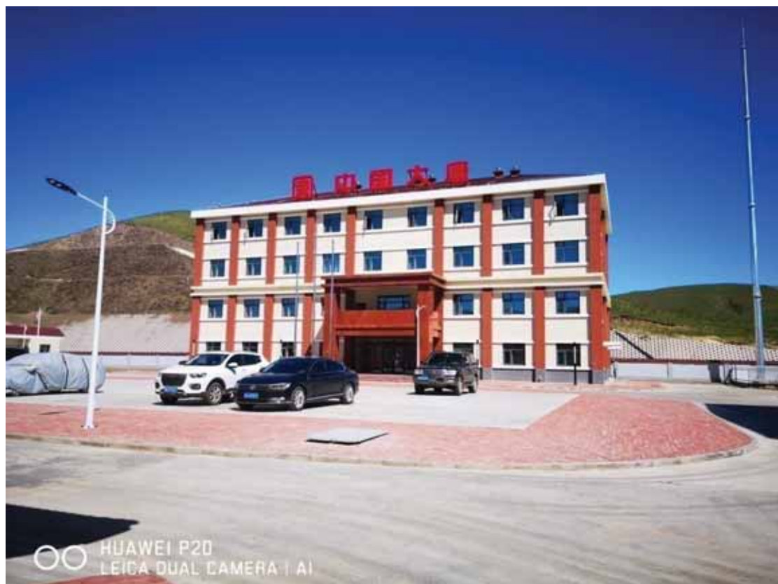
升压站透水砖铺装
