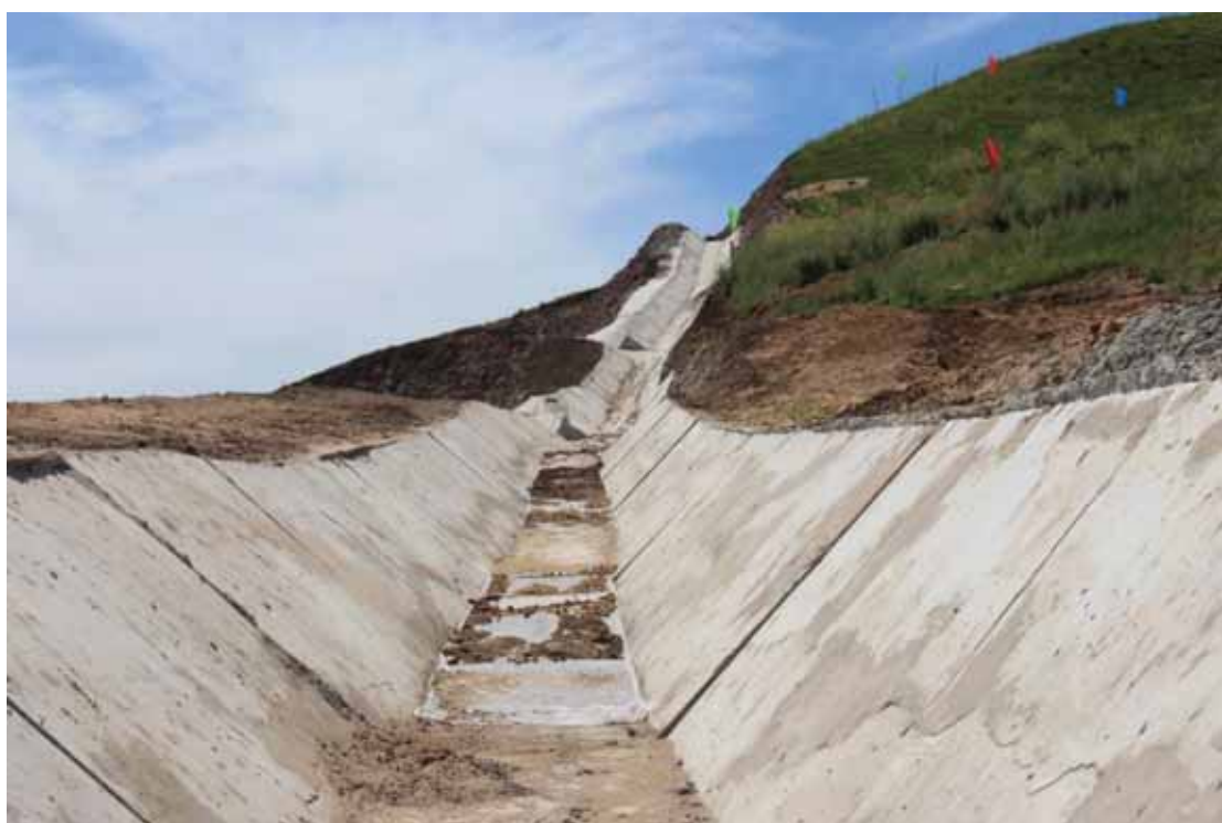
升压站混凝土排水沟
