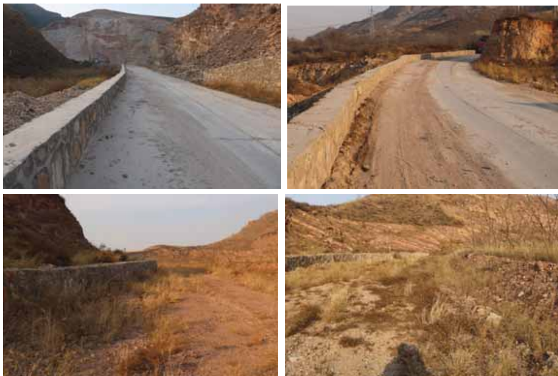
道路浆砌石挡墙、道路边埂
