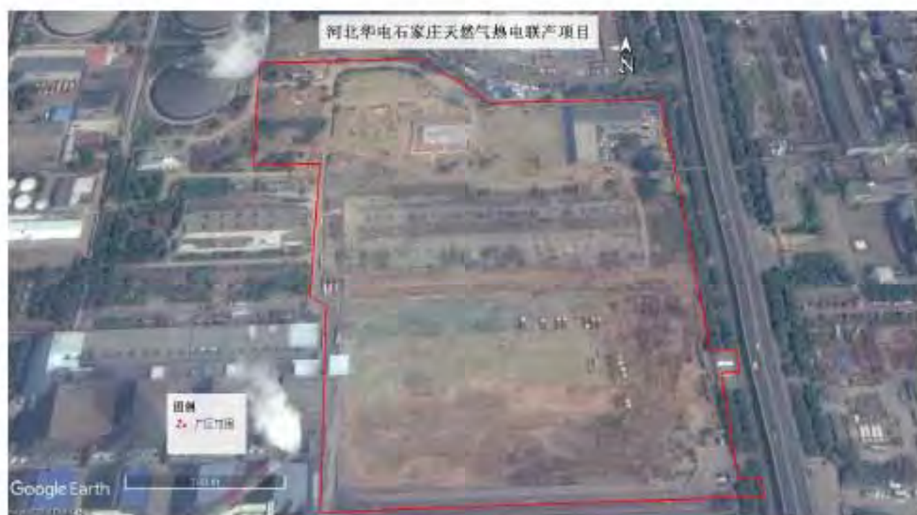
项目施工准备期遥感影像 (2016.5.10)
