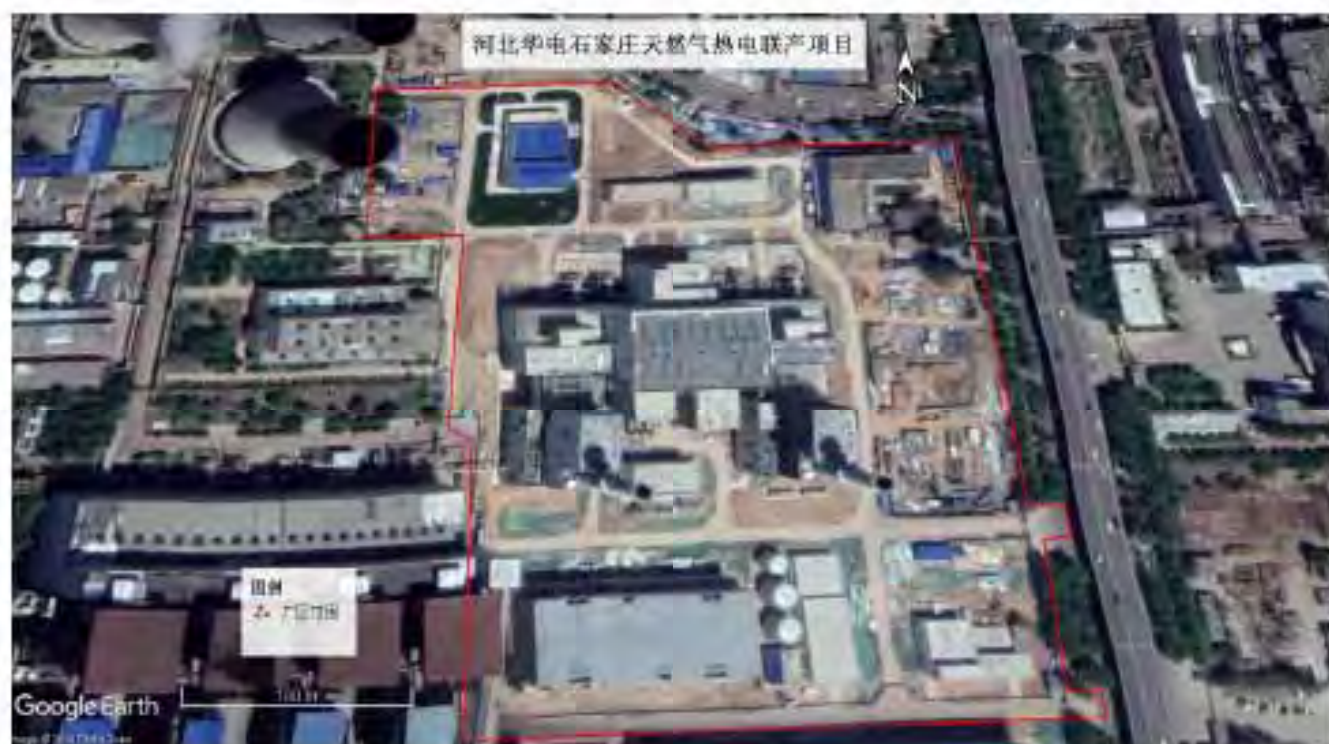
项目施工期遥感影像 (2018.5.3)
