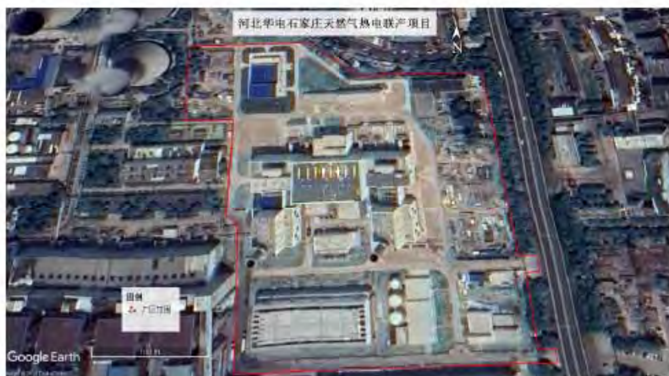
项目施工期遥感影像（2018.6.22）
