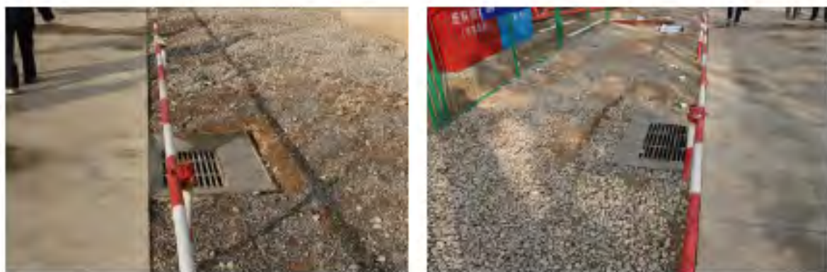
厂区雨水排水管道 (2016.10.31)
