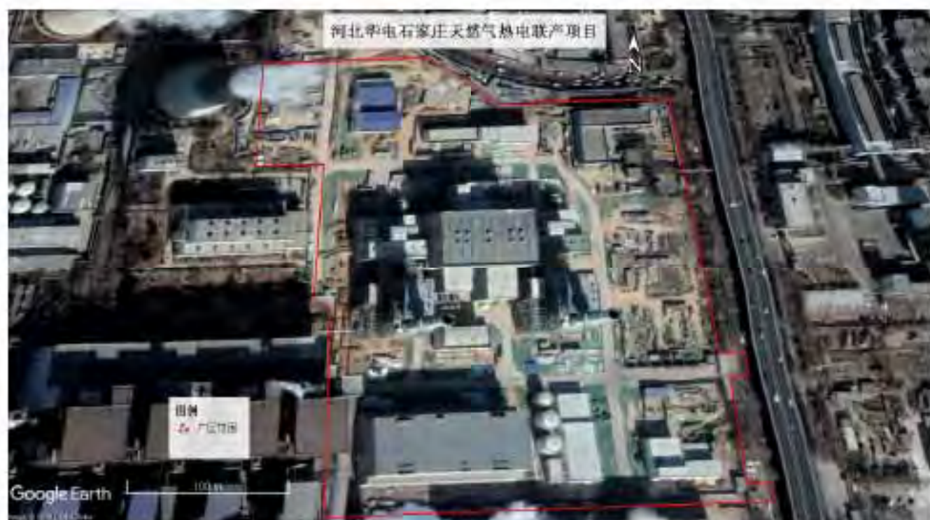
项目施工期遥感影像 (2018.2.4)
