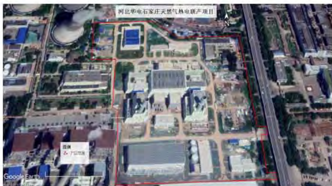
项目施工期遥感影像（2018.8.23）
