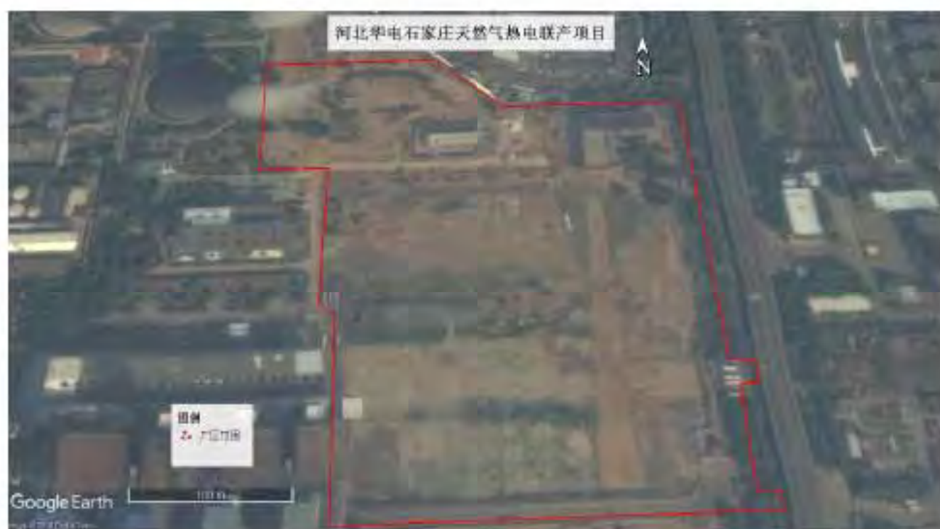
项目施工准备期遥感影像 (2016.9.4)
