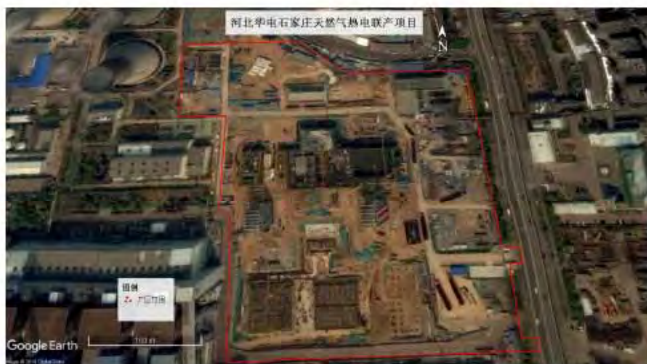
项目施工期遥感影像 (2017.4.3)
