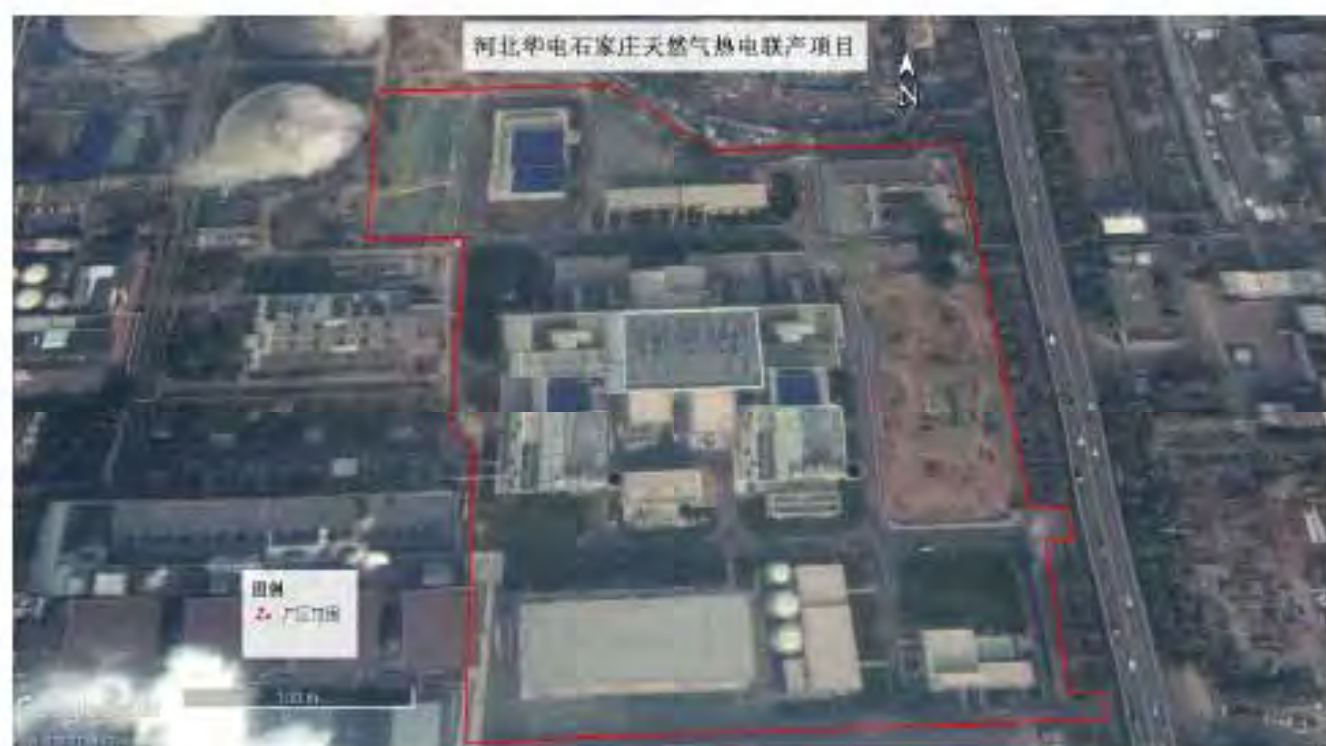
项目施工期遥感影像 (2018.11.13)
