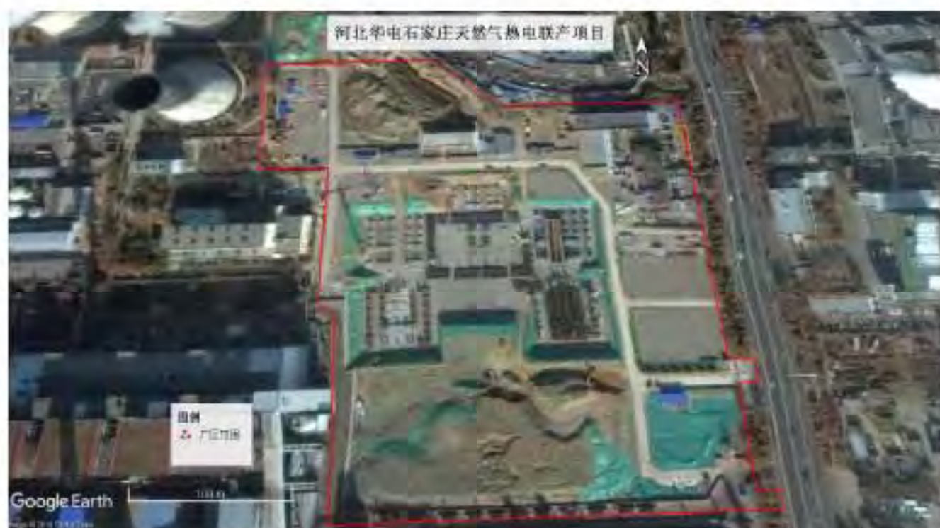
项目施工期遥感影像 (2017.1.12)
