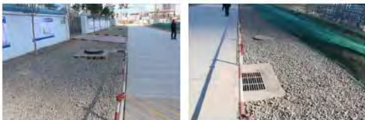
厂区雨水排水管道 (2017.2.10)
