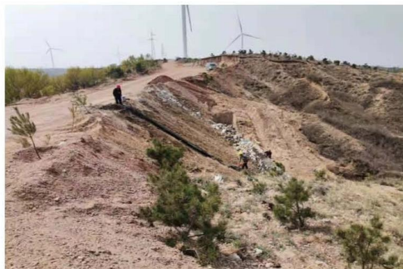
浆砌石挡墙施工2021.4
