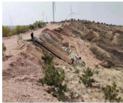
道路区浆砌石挡墙修筑
