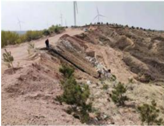
浆砌石挡墙施工2021.4
