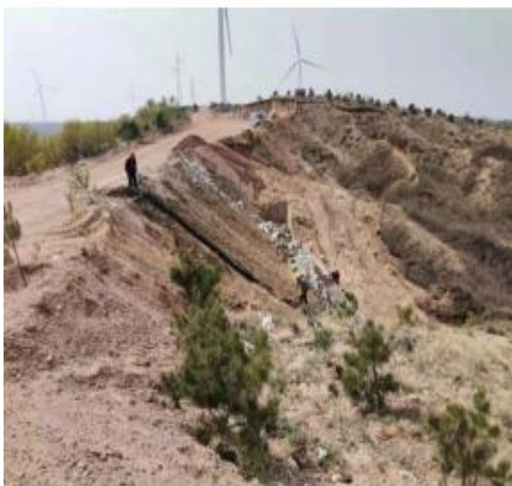
道路区浆砌石挡墙修筑
