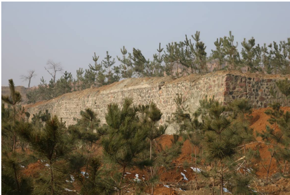
施工生产生活区浆砌石挡墙、栽植油松
